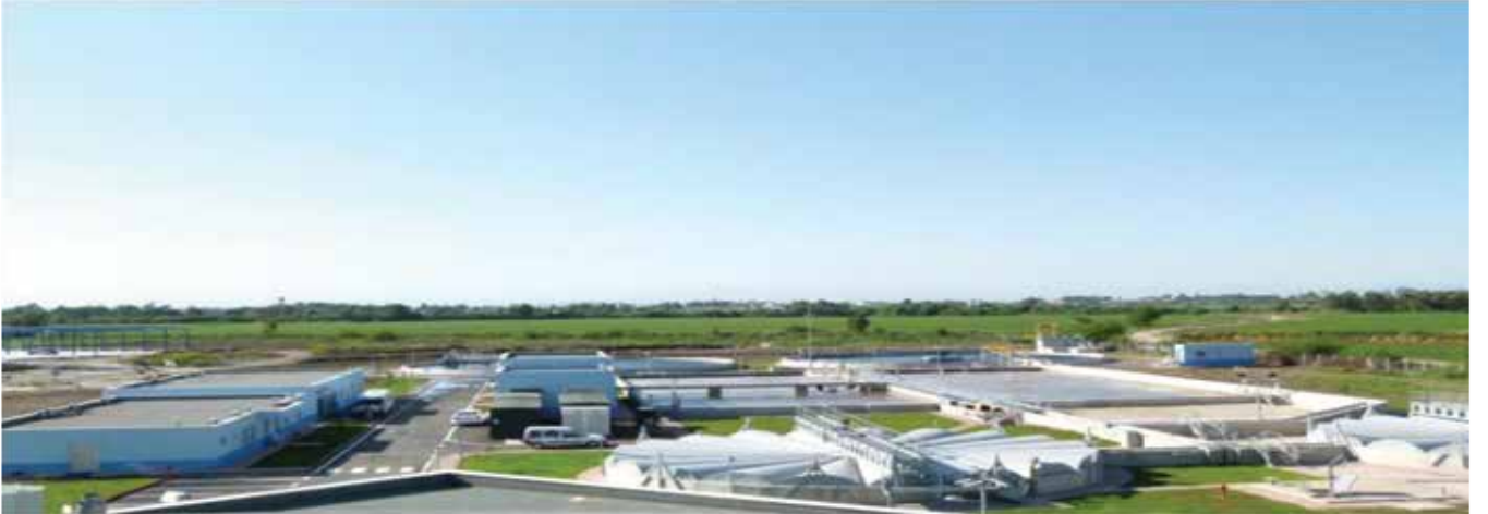
Ceyhan Atıksu Arıtma Tesisi
