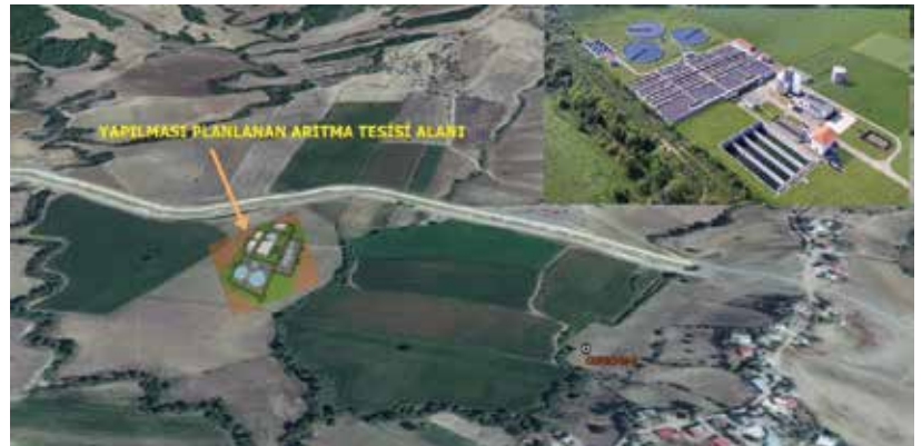
Yedigöze İçmesuyu Arıtma Tesisi Projesi
