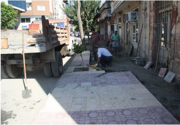
Çay Mahallesi Kaldırım Karo Çalışması
