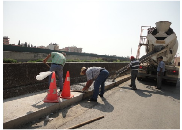
Barbaros Mahallesi Beton Kaldırım Bakım Onarı-
