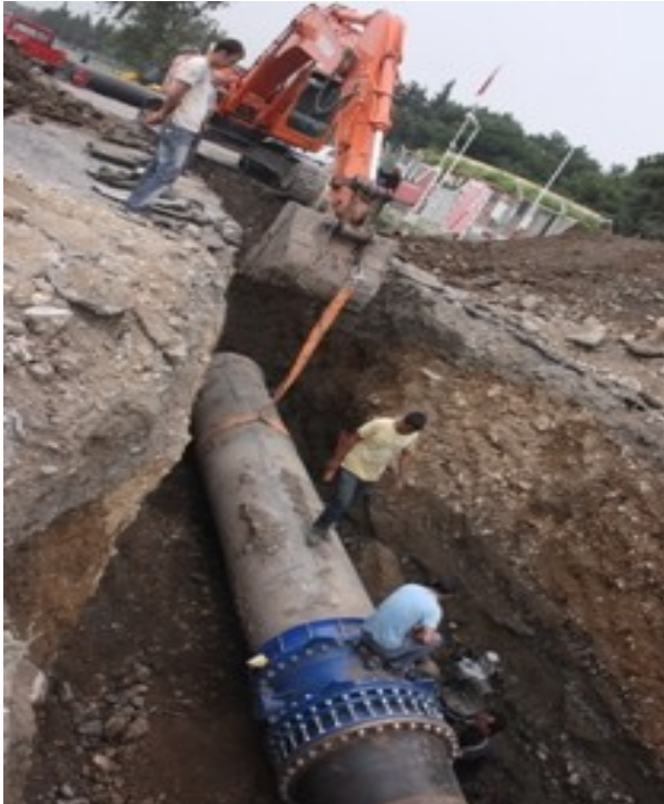
Yeni Su Şebekesi Döşenmesi
