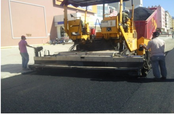
Yeni yapılan servis yollarının asfaltlanması çalışması
