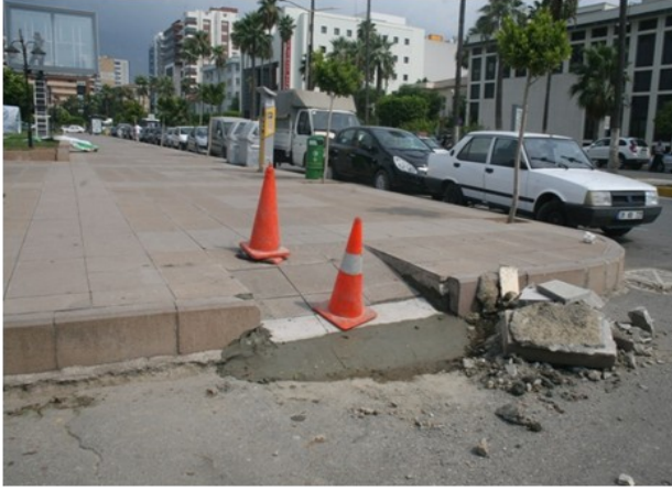
Atatürk Bulvarı Kaldırım Karo Bakım Onarımı
