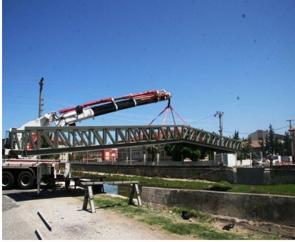
2 Adet Çelik Konstrüksiyondan Yaya Köprüsü Yapılması Yapım İşi
