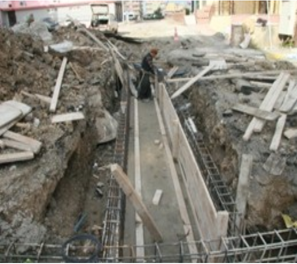
Yeni yağmur suyu hattı döşenmesi
