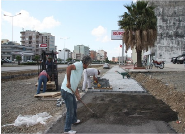
E-91 Servis Yollarına Kaldırım Parke Döşenmesi
