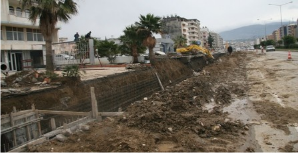
Yağmur suyu kanalı çalışması
