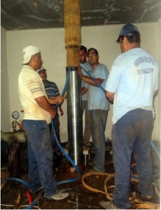
Pompa Bakım Çalışmaları
