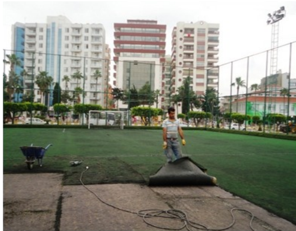
Spor Kompleksinin Bakım Onarımının yapılması
