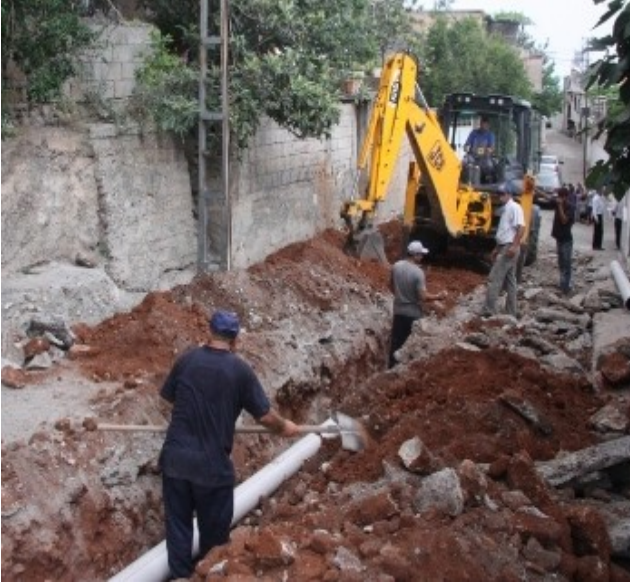
Yeni Kanal Döşenmesi
