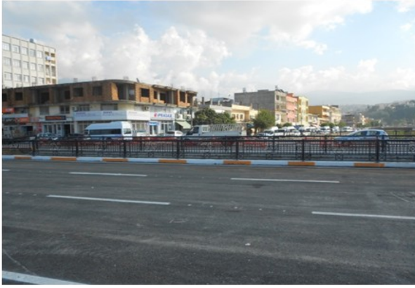
E-91 Karayolu üzerine yeni yapılan betonarme köprü'nün asfaltlama çalışması
