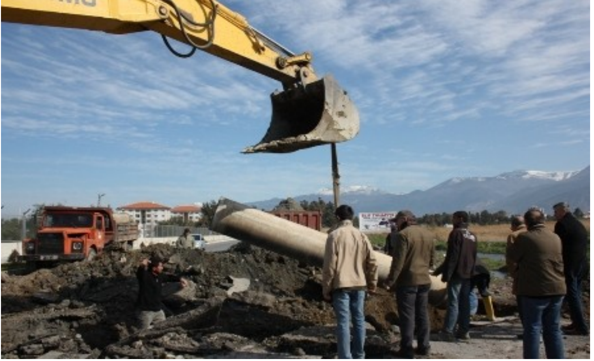
Meydan Mahallesi drenaj kanalı yapılması
