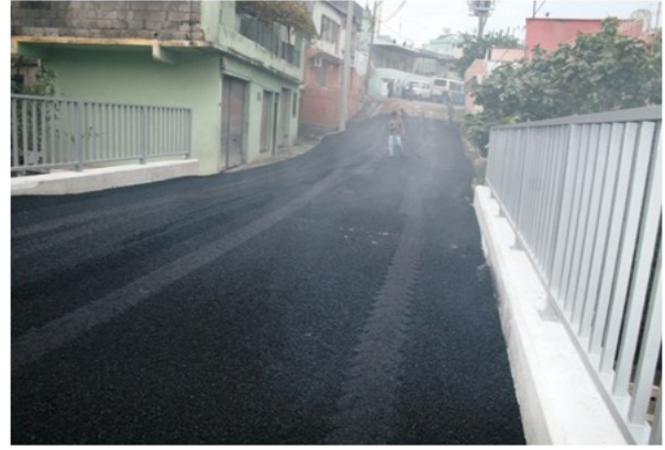
Yıldırım Tepe Mahallesinde yapılan betonarme menfezin asfaltlanması çalışması
