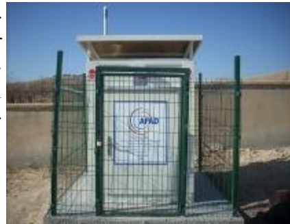
Deprem İvmeölçer istasyonlarının yer belirleme çalışmalarından görüntüler
