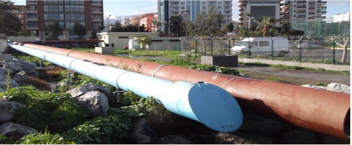
Sahil yükseltme istasyonunun bakım onarım çalışmaları yapılmıştır.
