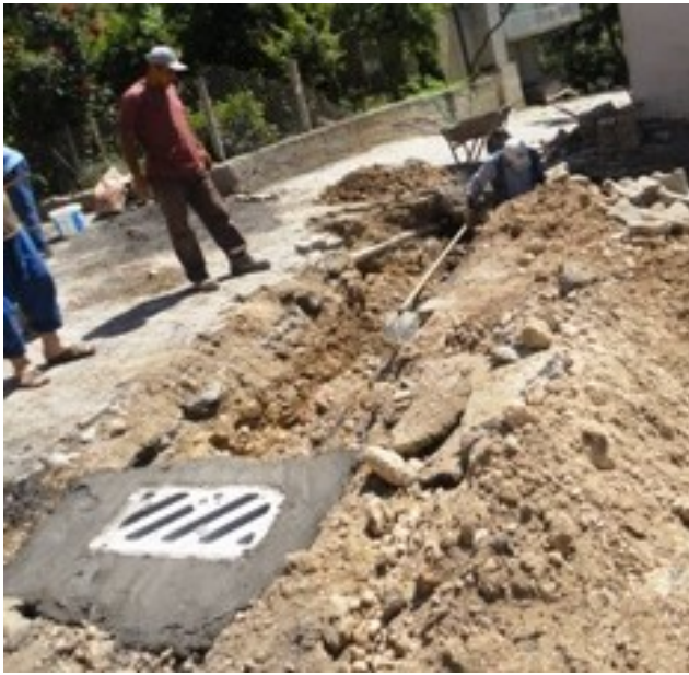
Yağmursuyu Cadde Ağızlığı Yapılması
