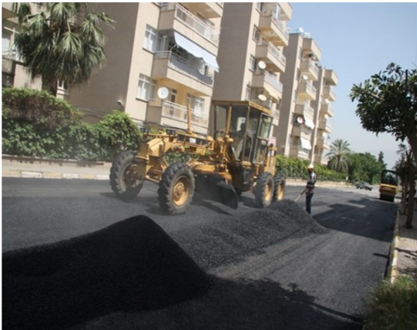
Asfalt bakım onarımlarının yapılması
