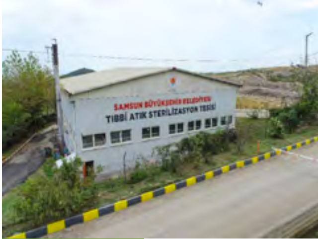
Tıbbi Atık Sterilizasyon Tesisi
