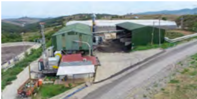
Çamur Kurutma Tesisi
