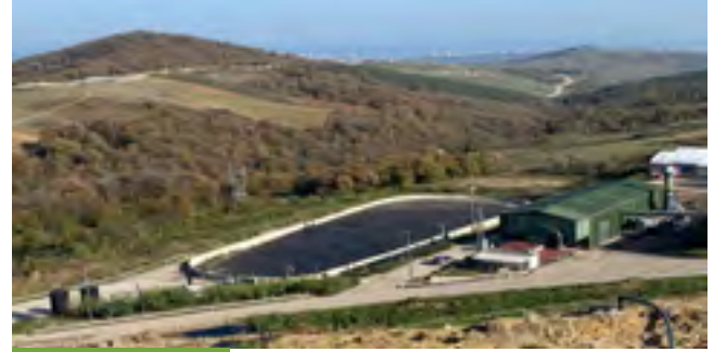
Sızıntı Suyu Havuzu
