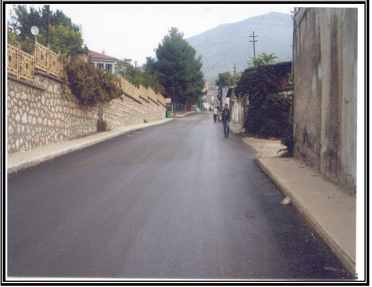
BETON ASFALT ÇALIŞMAMIZ
