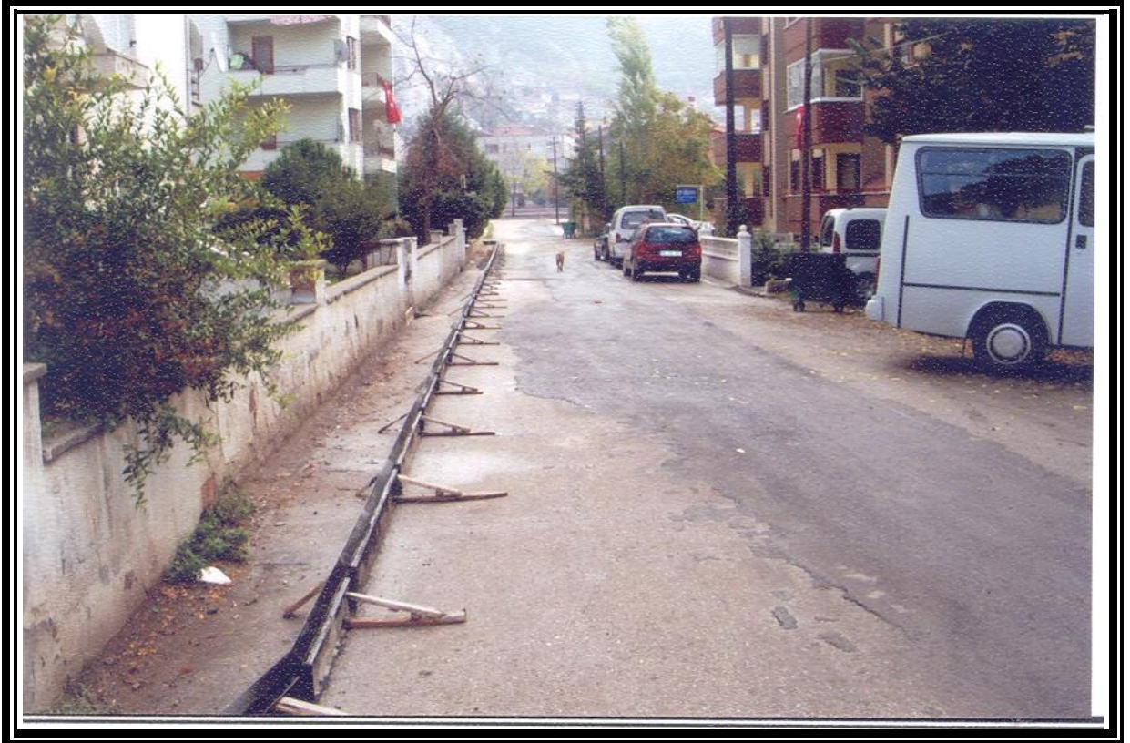
BETON TRETUVAR DÜZENLEMESİ 1
