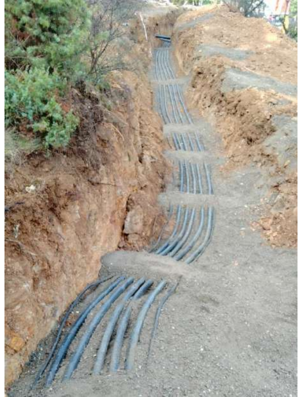
23- Göbel Termal Tesisleri yeni trafo için OG ve AG hat çalışmaları yapıldı.
