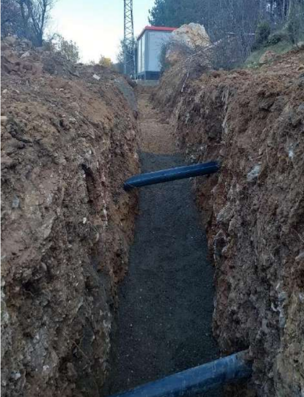
23- Göbel Termal Tesisleri yeni trafo için OG ve AG hat çalışmaları yapıldı.
