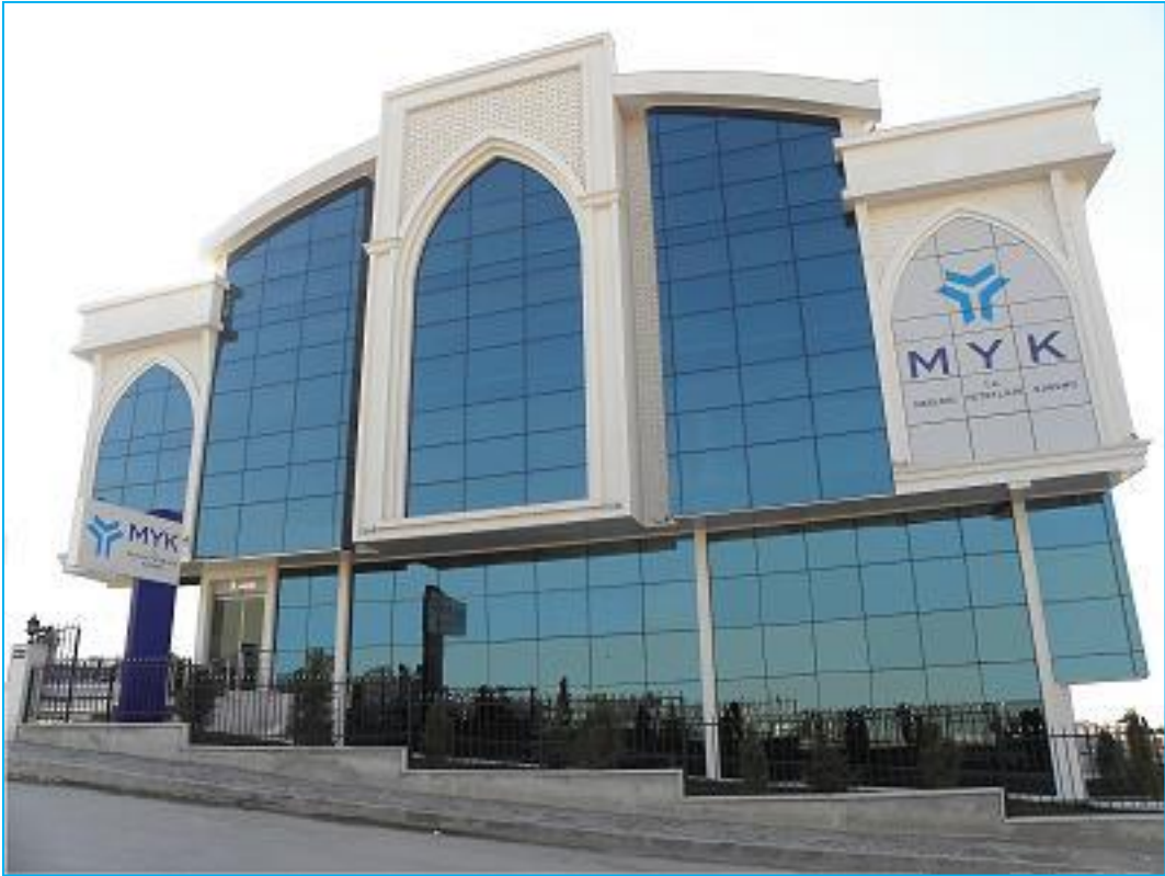
Resim 1: MYK Hizmet Binası
