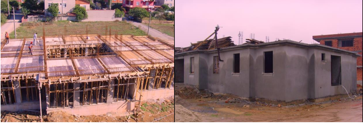
Sıra Söğütler Mahallesi Sağlık Ocağı çalışması
