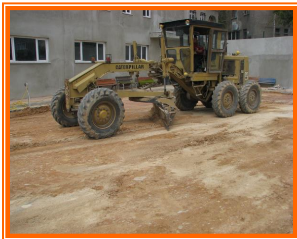
Asfalta hazırlanabilmesi için yeni açılan yollara toplamda 8,915.72 ton Plentmiks
