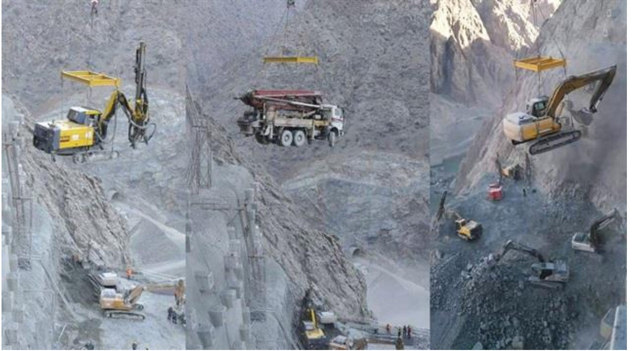
Artvin-Yusufeli Barajı İnşaatı
