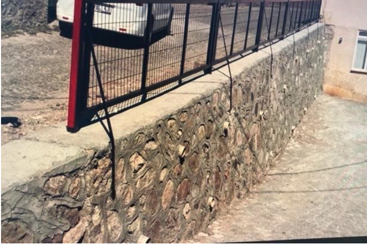
KOZLUCA MAH. TAŞ DUVAR YAPIM İŞİ
