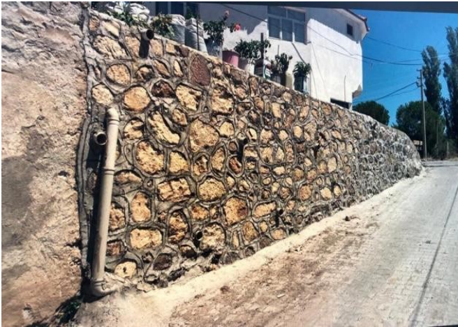
TIRMANLAR MAH.TAŞ DUVAR YAPIM İŞİ
