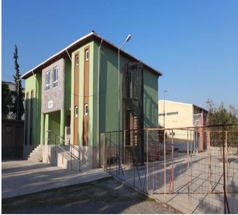
Fevzipaşa Okulu Bakım Onarım Yapım İşi
