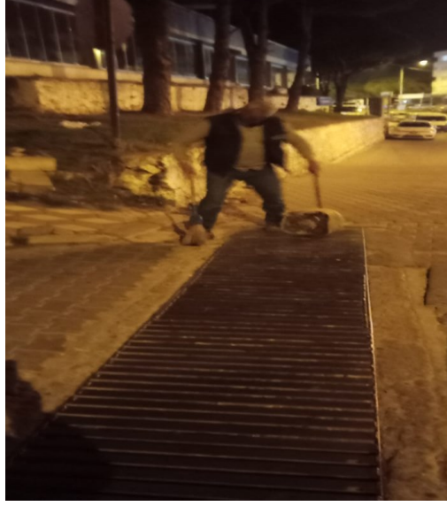
Şekil 5.21 Yağmur su kanallarının temizliği
