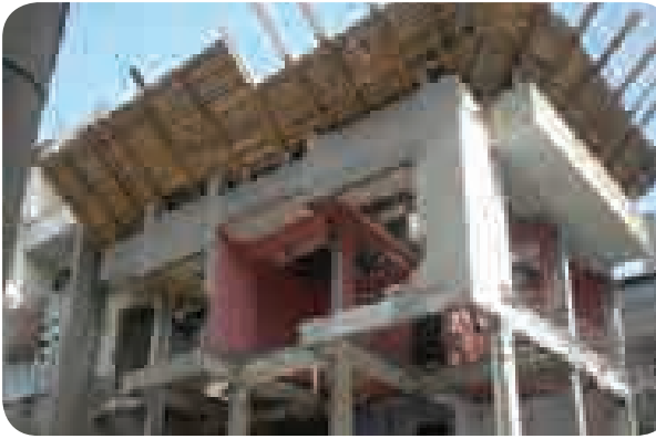
Yıkım Ruhsatı Alınmış Yapı Yıkımı
