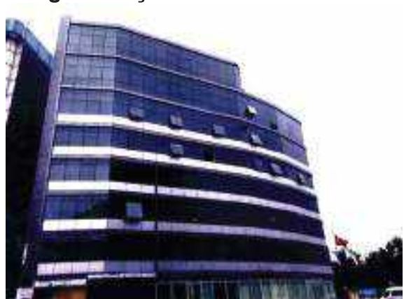
Kavacık Mah. 1011 Ada 87 Parsel
