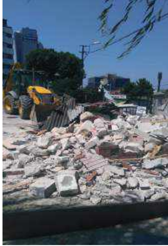
Rüzgarlıbahçe Emniyet Müdürlüğü Güvenlik Kulübesi Yıkım
