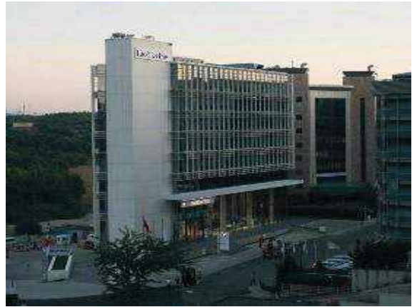
Rüzgarlıbahçe Mah. 1267 Ada 3 Parsel
