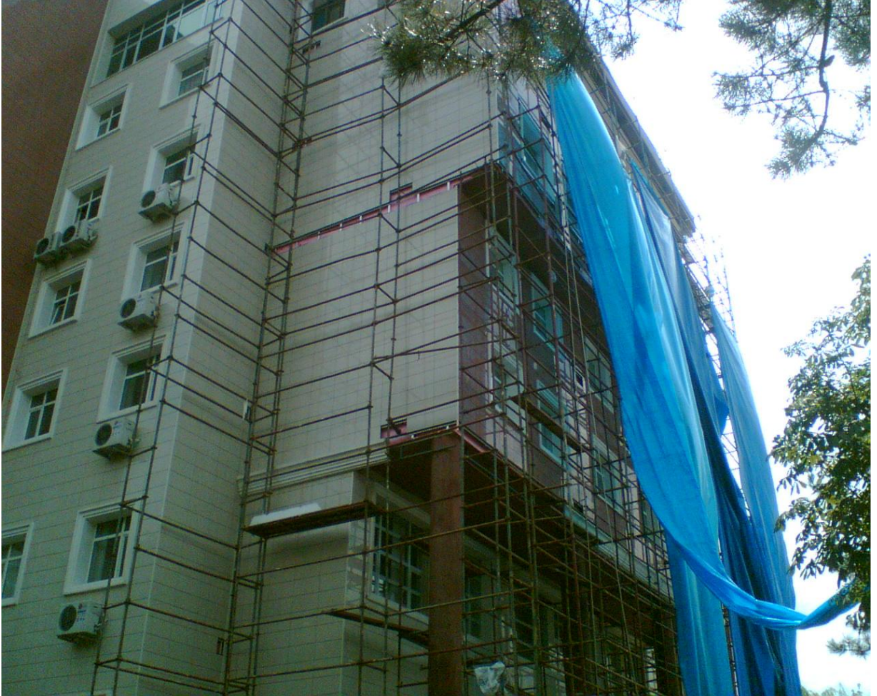
Rektörlük binasının dış cephe kaplama çalışmaları
