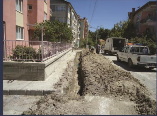
Altyapı inşaatlarında çevre güvenliğini sağlandı.
