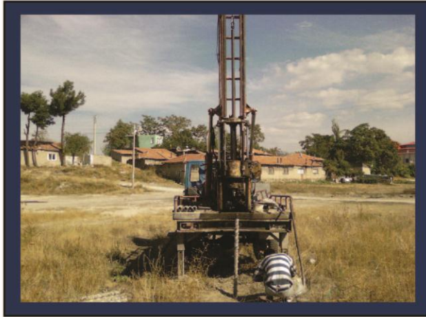
Yerinde zemin etüt incelemeleri yapıldı.
