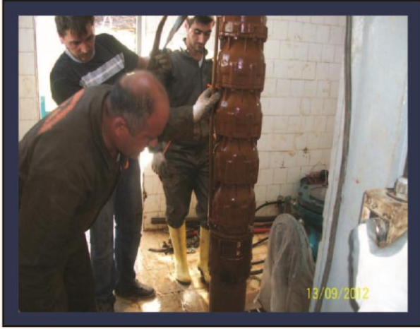
Kuyu tamir ve bakımları yapıldı.
