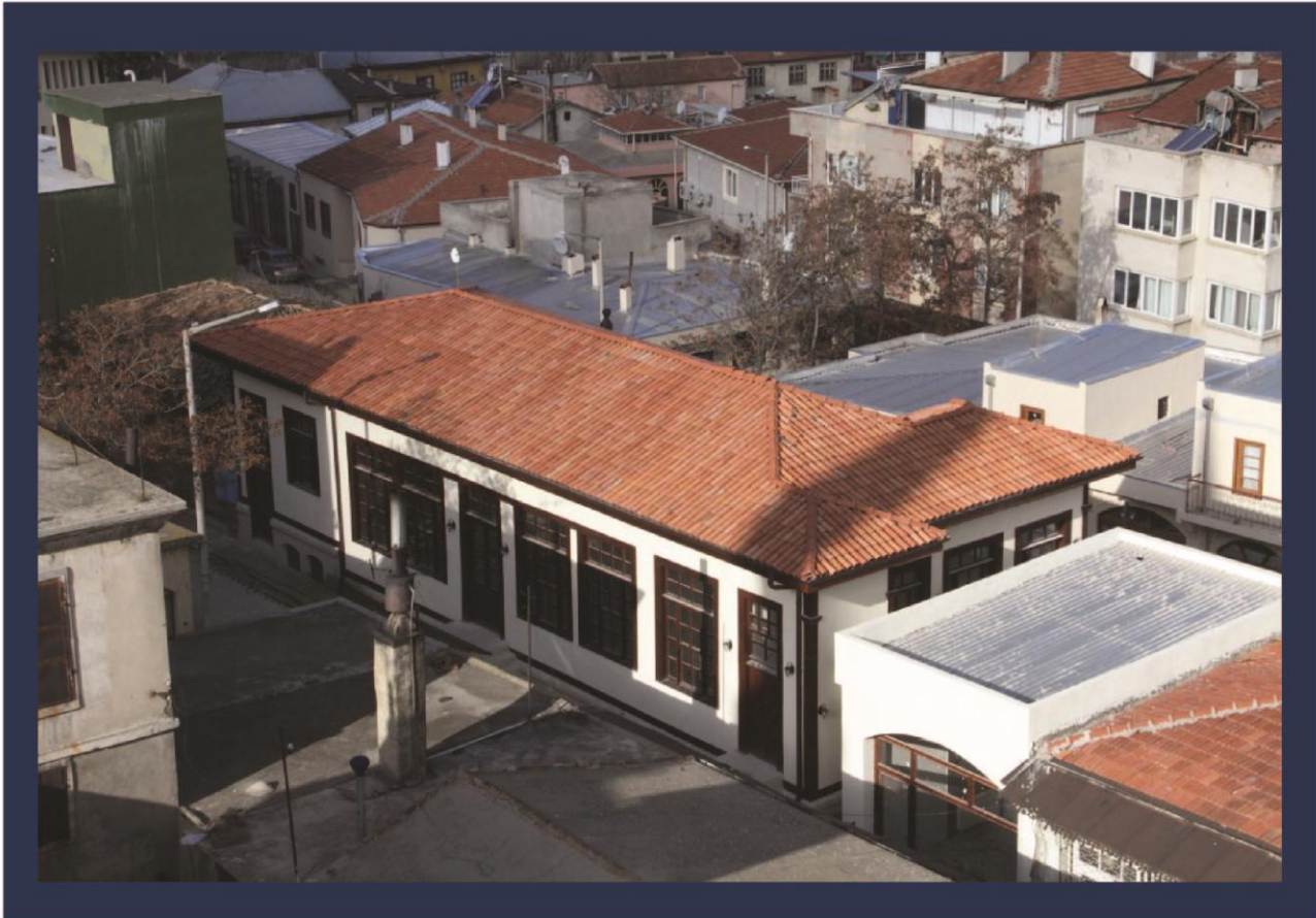
Eski Şehir Kulübü restorasyon çalışmaları tamamlandı.
