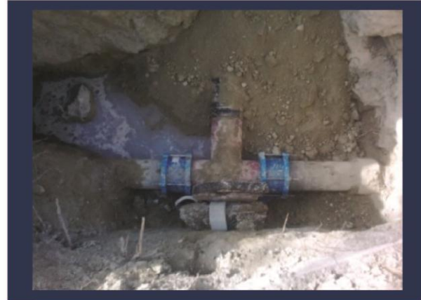
AÇB boruları PVC borularla değiştirildi.
