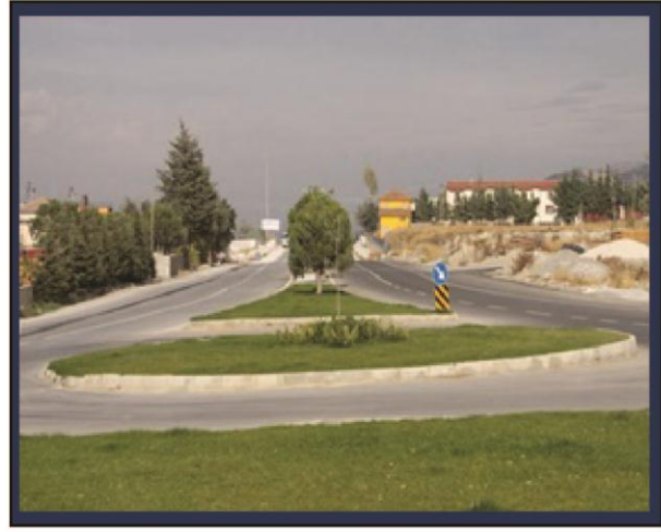
Sanayi Altı Orta Refüj Düzenlenmesi Tamamlandı.
