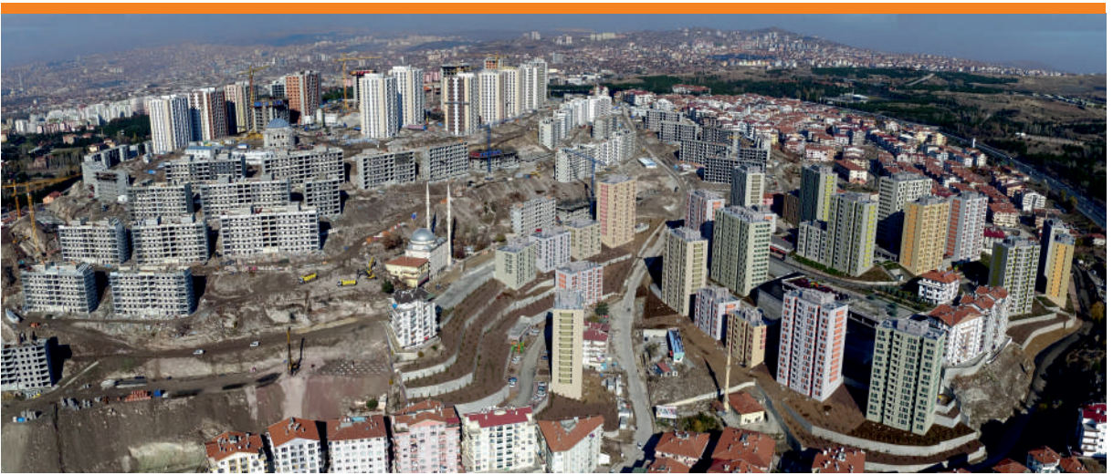
ALTIAĞAÇ-KARAAĞAÇ VE HÜSEYİNGAZİ MAHALLELERİ KENTSEL DÖNÜŞÜM YERİNİN YENİ HALİ
