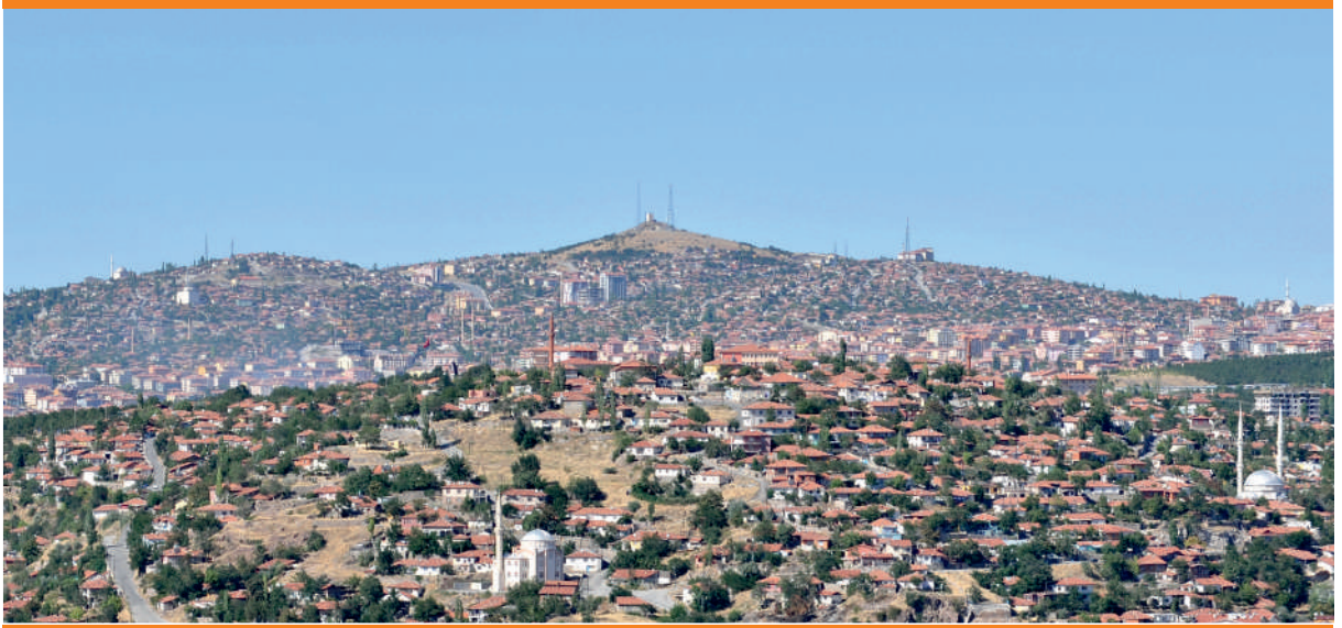
ALTIAĞAÇ-KARAAĞAÇ VE HÜSEYİNGAZİ MAHALLELERİ KENTSEL DÖNÜŞÜM YERİNİN ESKİ HALİ
