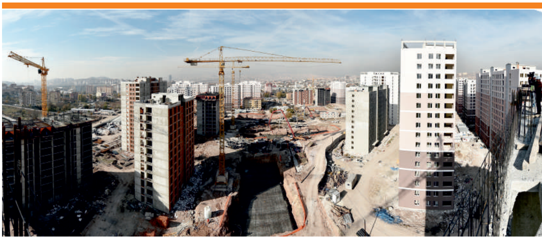
DİRİLİŞ (GÜLSEREN - ANAYURT) MAHALLESİ KENTSEL DÖNÜŞÜM PROJESİ İNŞAAT HALİ
