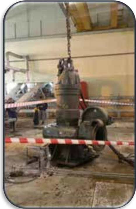
Bakımdan gelen 135 kW dalgıç pompa montajı yapıldı.
