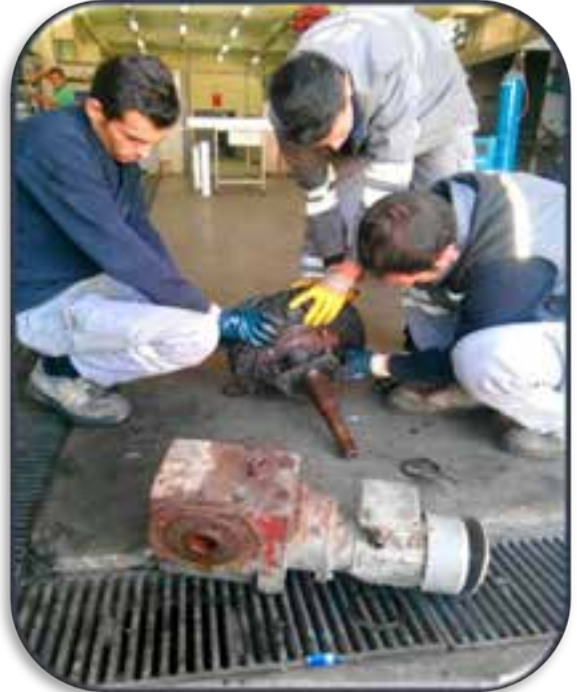
Kum yağ tutucu gezer köprü tekerleği yenisi ile değiştirildi.
