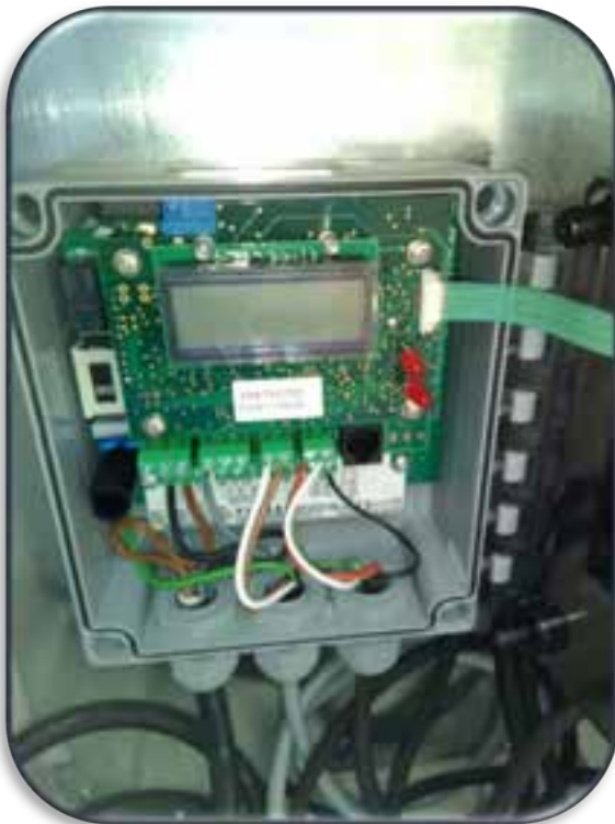
Çifteler Atıksu Arıtma Tesisi geri devir yapısındaki ultrasonik seviye ölçer arızası giderildi.
