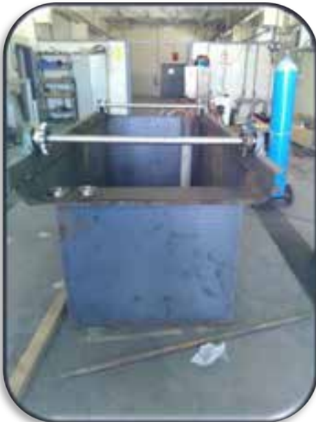
Çifteler Atıksu Arıtma Tesisinde kullanılmak üzere atölyede imalatı yapılan yağ tutucu yerine monte edildi.
