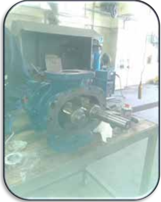
Çifteler Atıksu Arıtma Tesisi blower rulmanları değiştirildi.
