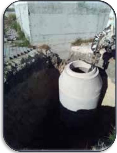
Çifteler Atıksu Arıtma Tesisinde geri devir vana odaları yapıldı.
