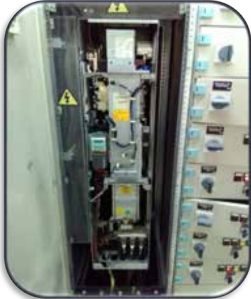
I. Kademe Atıksu Arıtma Tesisleri blower sürücüsü fanı değiştirildi.
