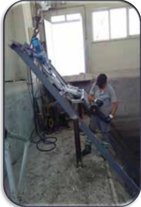
By-pass yapısına atölyede imalatı tamamlanan otomatik ızgaranın montajı yapıldı.
