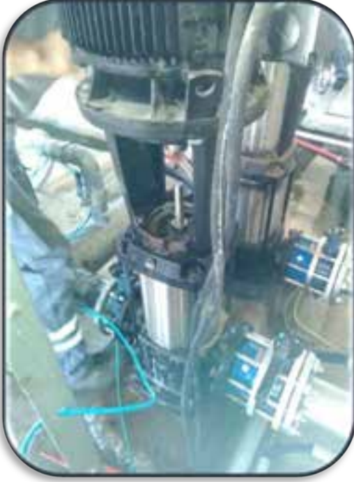
Yeşil alan sulama pompaları fan, fan odası ve keçeleri değiştirildi.
