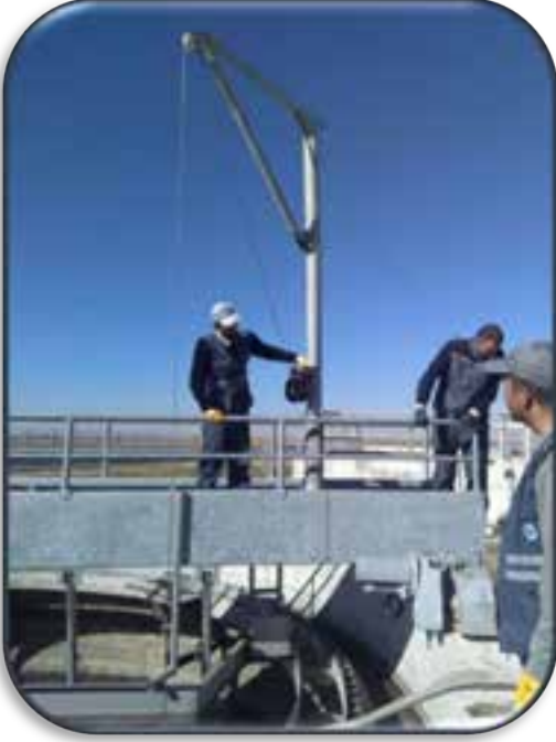
Çifteler Atıksu Arıtma Tesisi gezer köprülerine pergel vinç montajı yapıldı.
