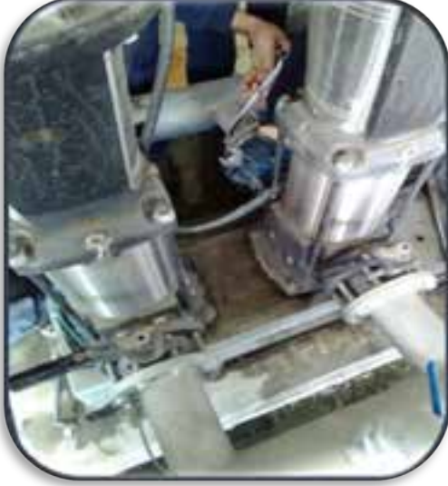
Servis suyu pompalarının çekvalf ve keçeleri değiştirildi.
