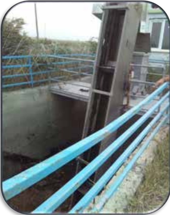
Çifteler Atıksu Arıtma Tesisi kaba ve ince ızgaralarının bakımları yapılarak yerine montajı yapıldı.
