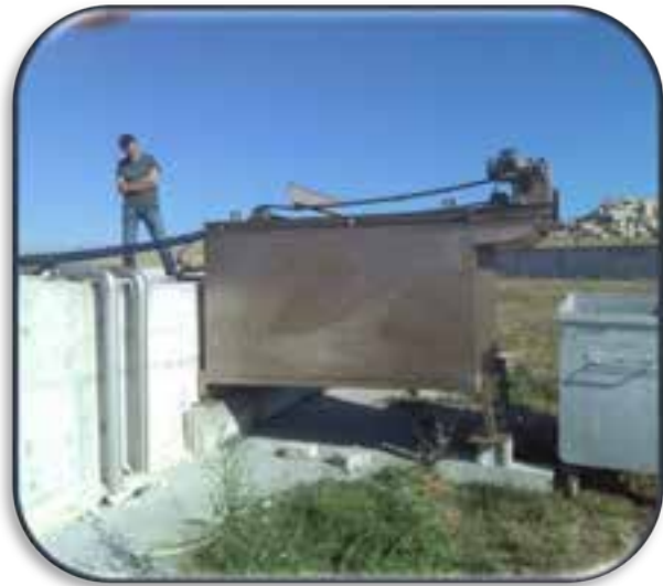
Çifteler Atıksu Arıtma Tesisinde kullanılmak üzere atölyede imalatı yapılan yağ tutucu yerine monte edildi.
