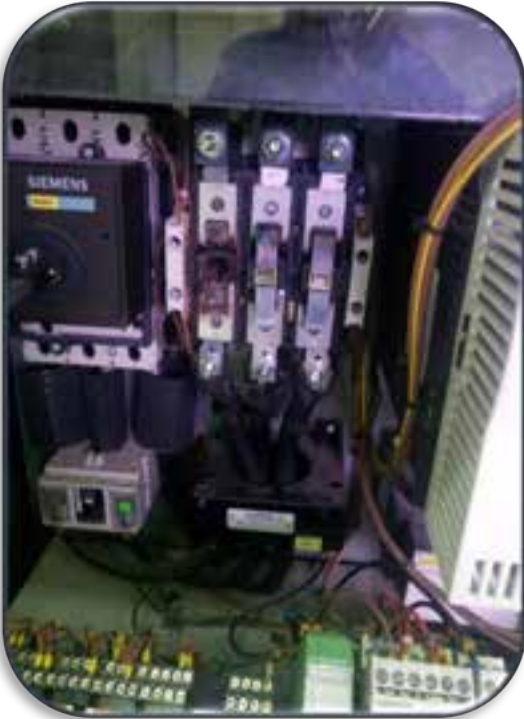
135 kW dalgıç pompa kontaktörü değiştirildi.
