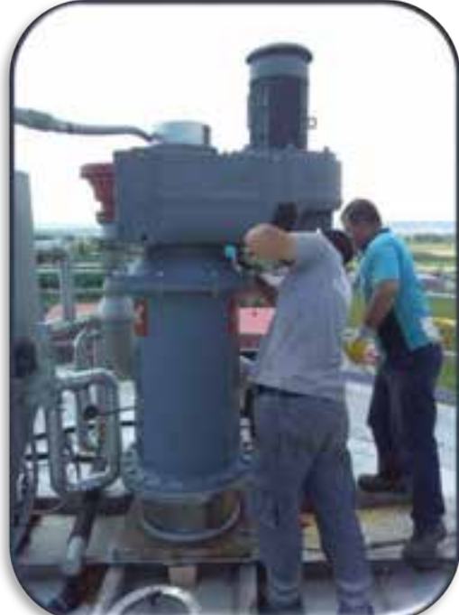
Çürütücü tankı karıştırıcı redüktörlerinin bakımı yapıldı.
