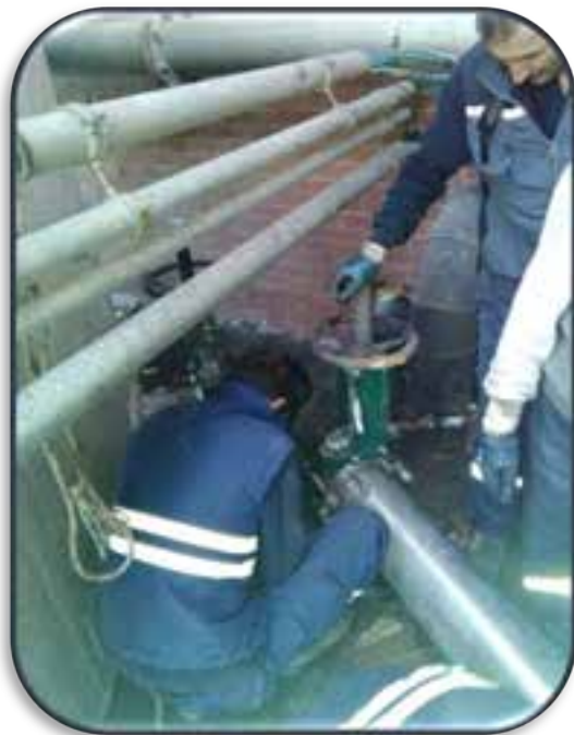
Çürütücü besleme pompaları, besleme hattı tadilatı yapıldı.
