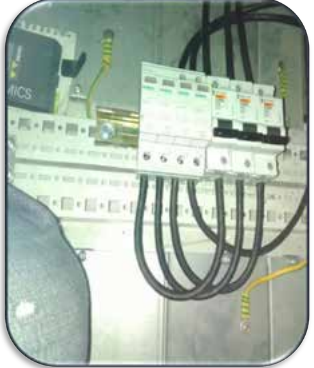
Gaz jeneratörleri elektrik panosuna parafodur montajı yapıldı.
