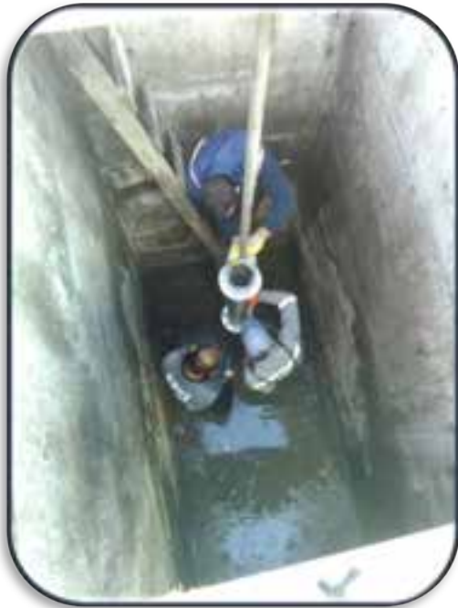
Çifteler Atıksu Arıtma Tesisi geri devir sifon borularının kot ayarlamaları yapıldı.
