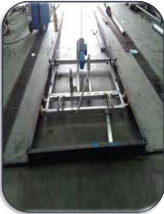
By-pass yapısına atölyede imalatı tamamlanan otomatik ızgaranın montajı yapıldı.
