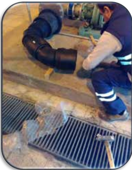
Çürütücü besleme pompaları, besleme hattı tadilatı yapıldı.
