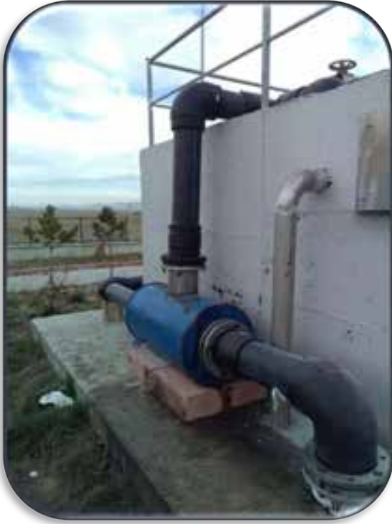
Sivrihisar Atıksu Arıtma Tesisi dağıtım yapısına orantılı atıksu girişi sağlanması için tadilat yapıldı.
