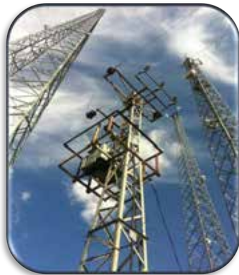
Derinkuyu ENH trafo tadilat işi
