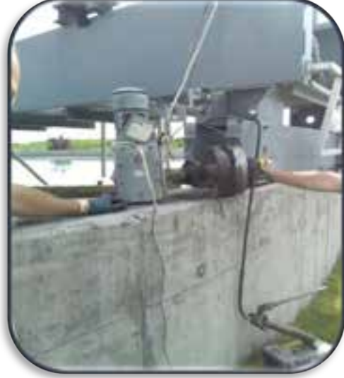
Ön çökeltim havuzu gezer köprü tekerleği yenisi ile değiştirildi.
