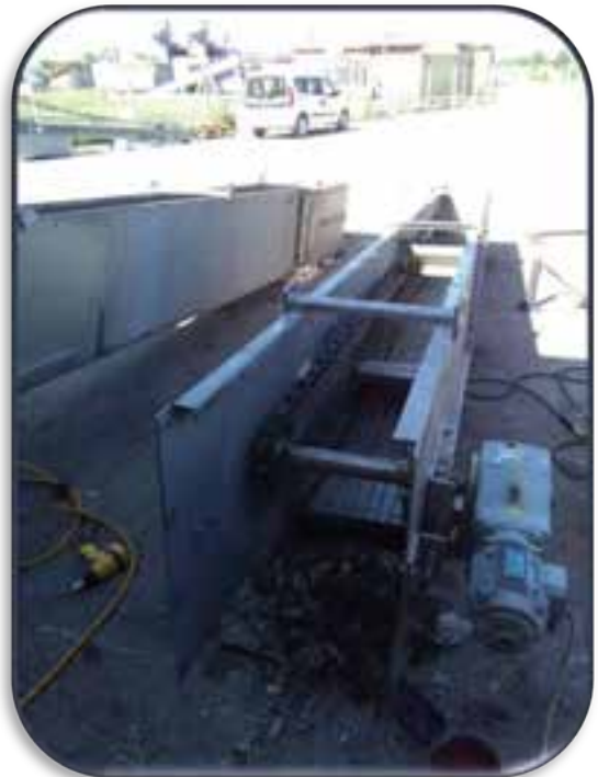
Çifteler Atıksu Arıtma Tesisi kaba ve ince ızgaralarının bakımları yapılarak yerine montajı yapıldı.
