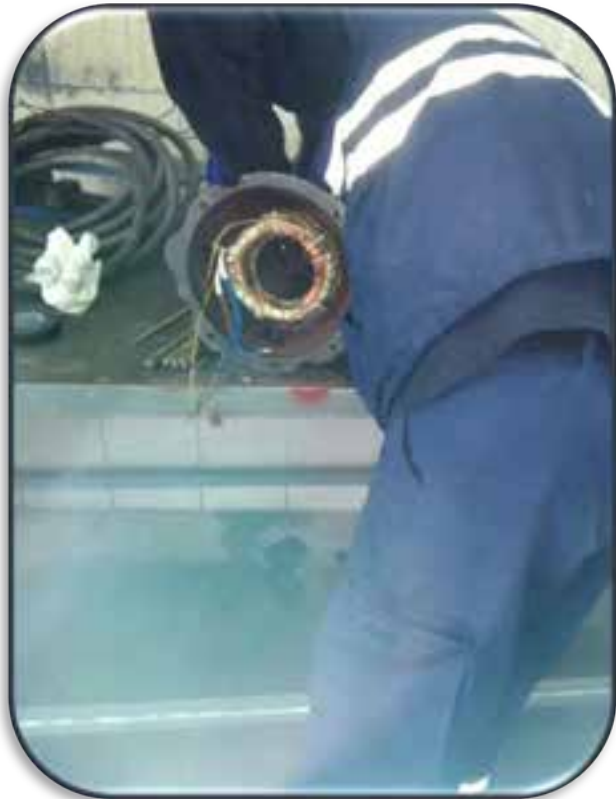
Sarımdan gelen dalgıç pompalar montajı yapılarak kullanıma hazır hale getirildi.
