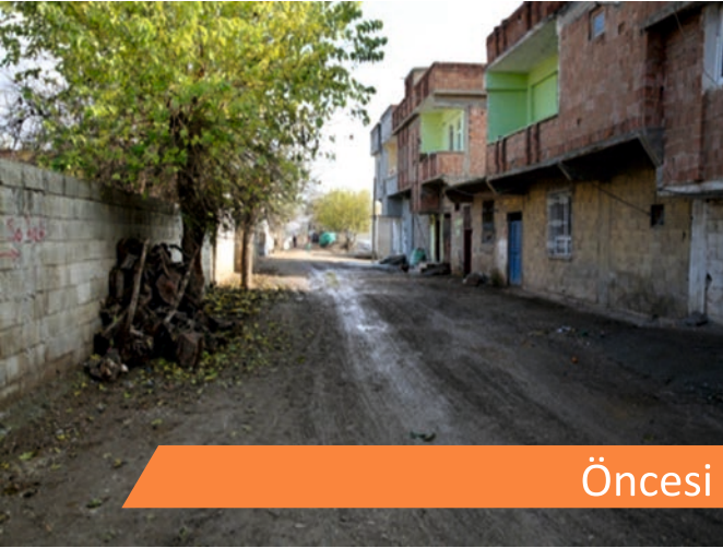
Gürcütepe Mahallesinde stabilize yol çalışması
