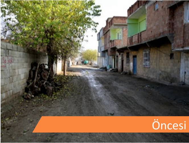
Gürcütepe Mahallesinde stabilize yol çalışması
