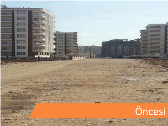
Karşıyaka Mahallesinde yeni yol açma çalışması
