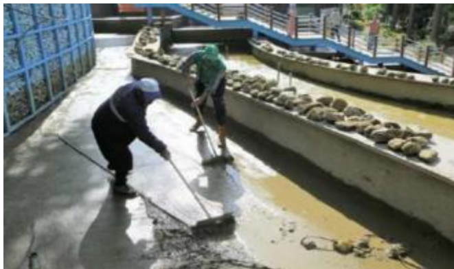
*Park alanlarında bulunan havuzların temizleme çalışması
