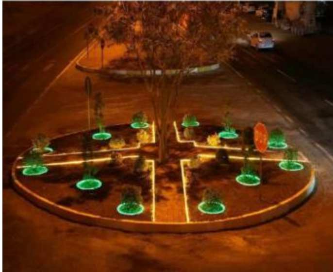
*Elazığ –Diyarbakır Karayolu kavşak çalışması
