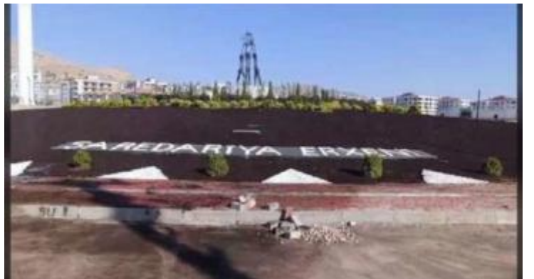
* Yaşam Kavşağı yapımı ve düzenlemesi
