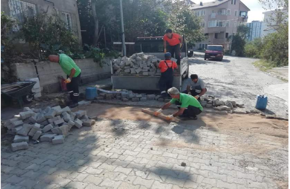
Bucak Mahallesi 455 Nolu Sokak Parke Bakım-Onarım Çalışması
