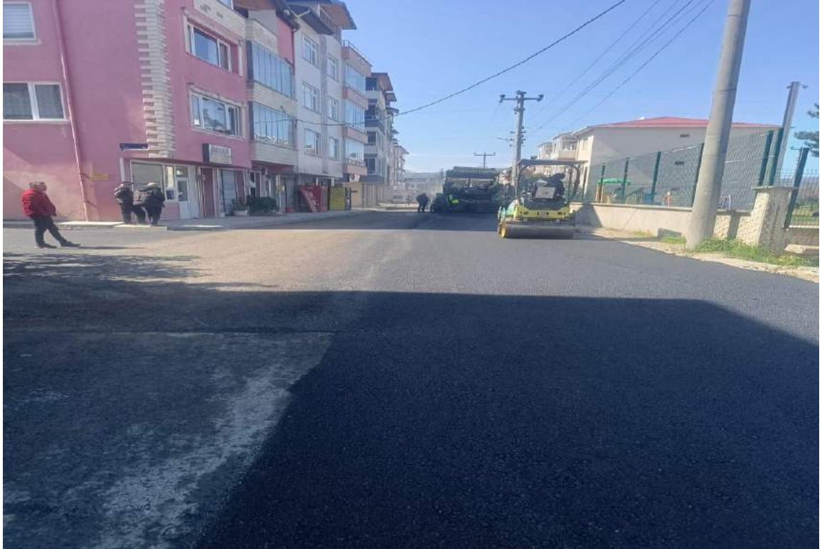
Kumbaşı Mahallesi 1 Nolu Sokak Asfaltlama İşi İlk/Son Hali
