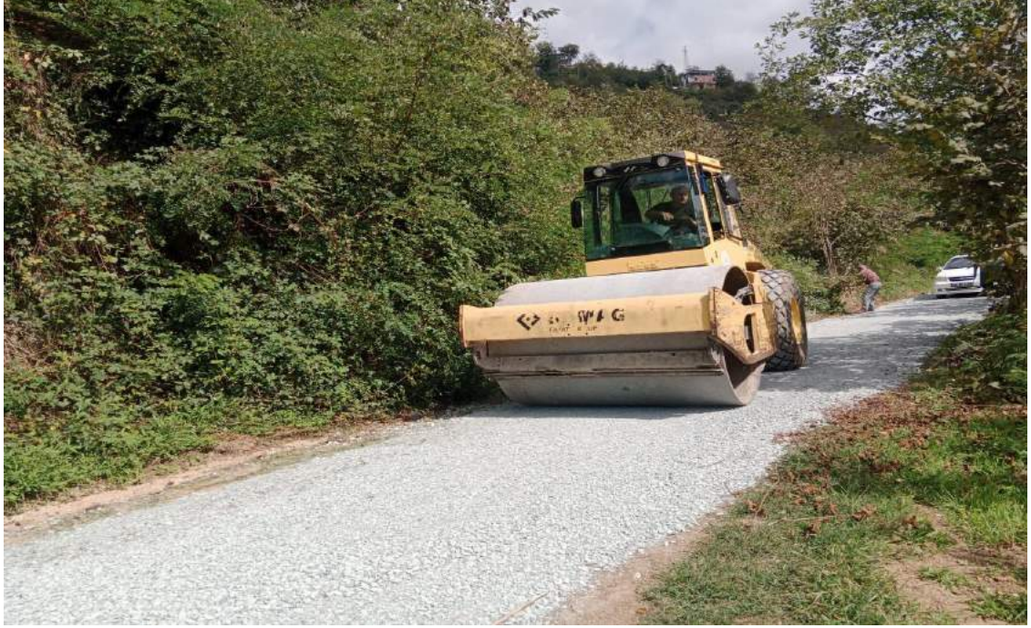
Kovancı Mahallesi Karavelioğlu Sokak Yol Bakım-Onarım Çalışması
