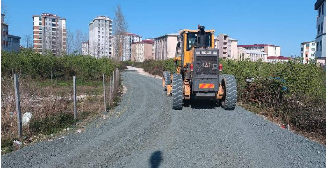
Cumhuriyet Mahallesi 1367 Nolu Sokak Yol Bakım-Onarım Çalışması
