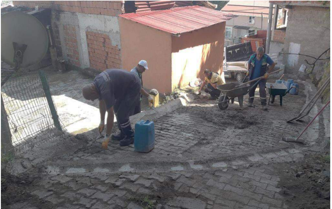
Aziziye Mahallesi 165 Nolu Sokak Oluk Yapım İşi
