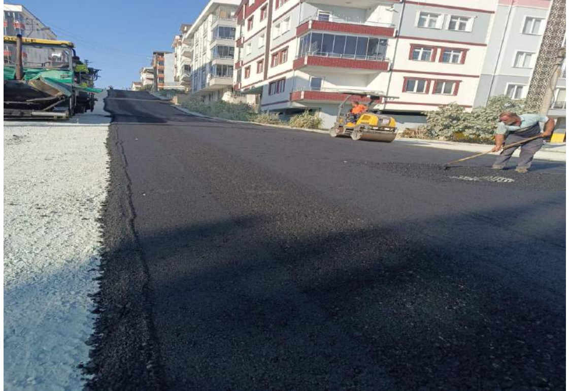
Şahincili Mahallesi 609 Nolu Sokak Asfaltlama İşi
