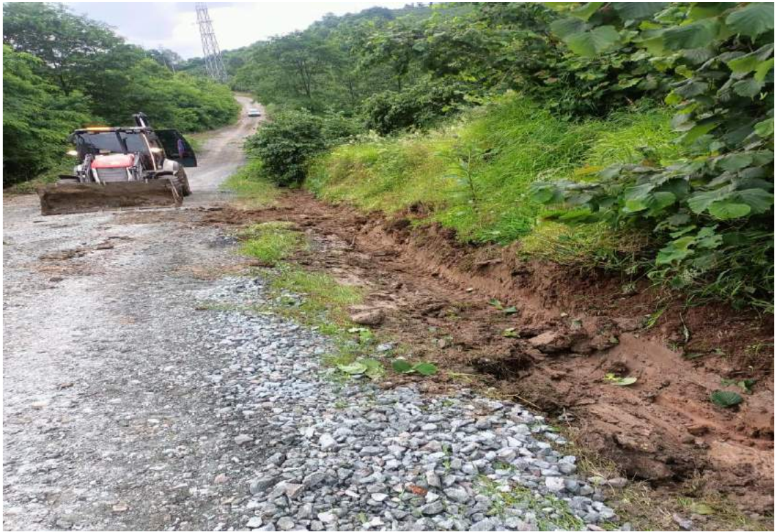
Yarışlı Mahallesi Kanal Temizleme Çalışması
