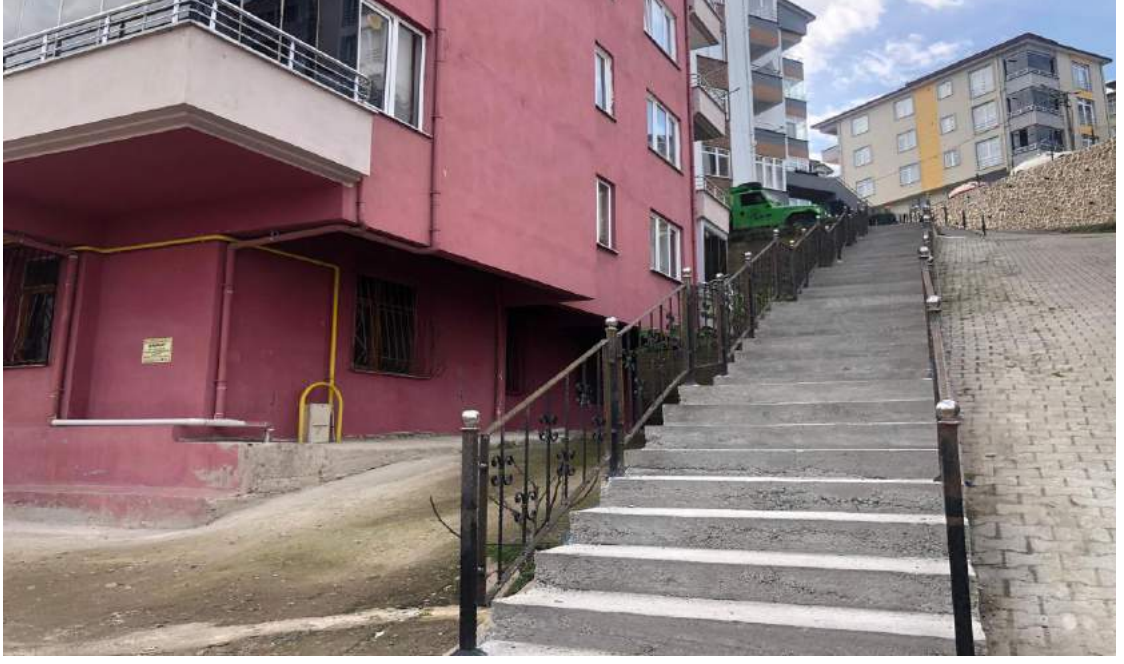
Selimiye Mahallesi 213 Nolu Sokak Merdiven Yapım İşi
