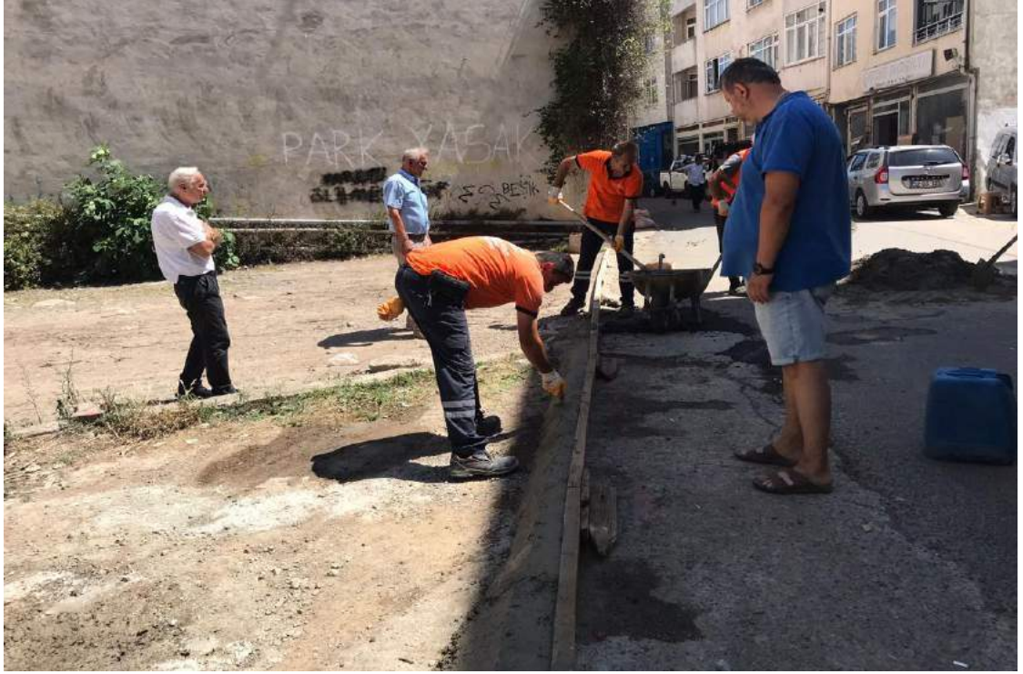
Bucak Mahallesi 341 Nolu Sokak Beton Bordür Yapım İşi
