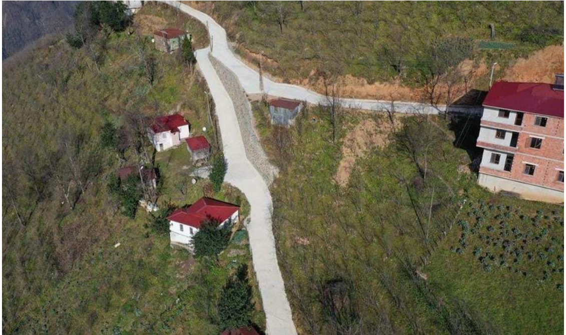
Alisayvan Mahallesi Camiyanı Sokak ve Körükyanı Sokak Beton Yol Yapım İşi
