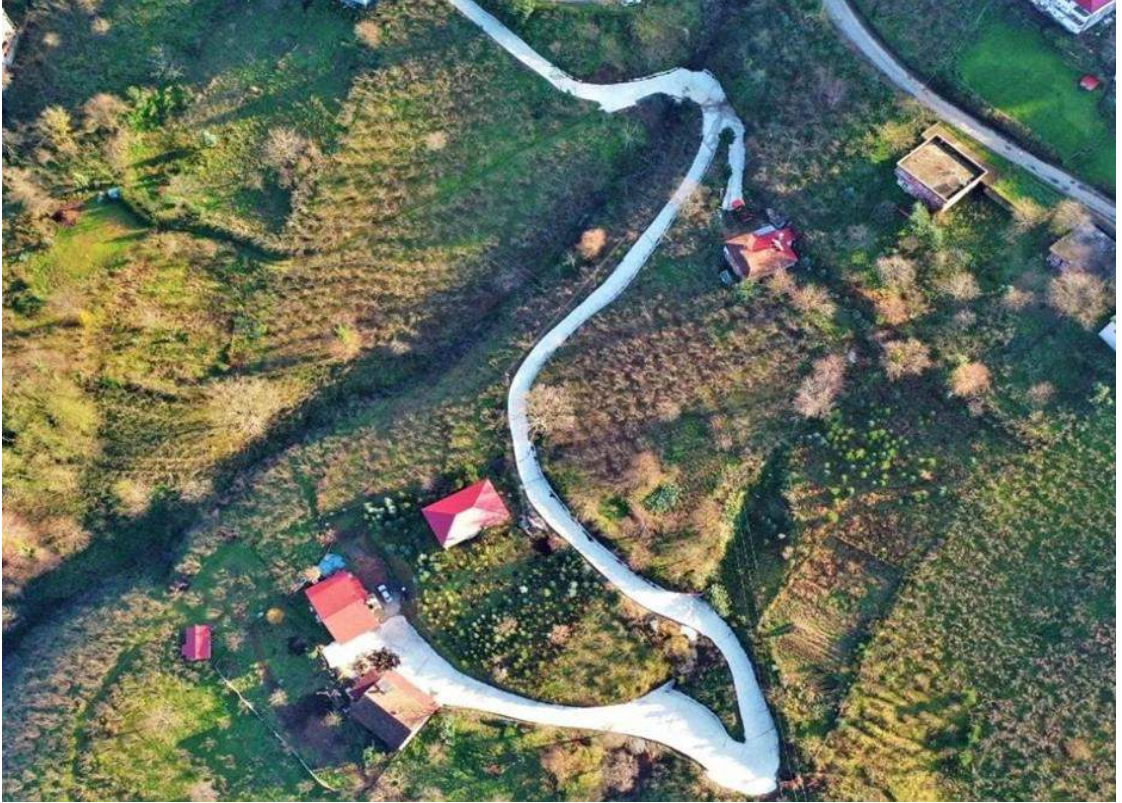
Karaoluk Mahallesi Kiliseyanı 1 ve 2 Nolu Sokak Beton Yol Yapım İşı
