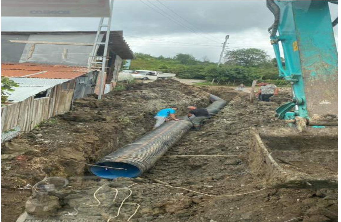
Teyneli Mahallesi Güvendikli Sokak Boru Atımı
