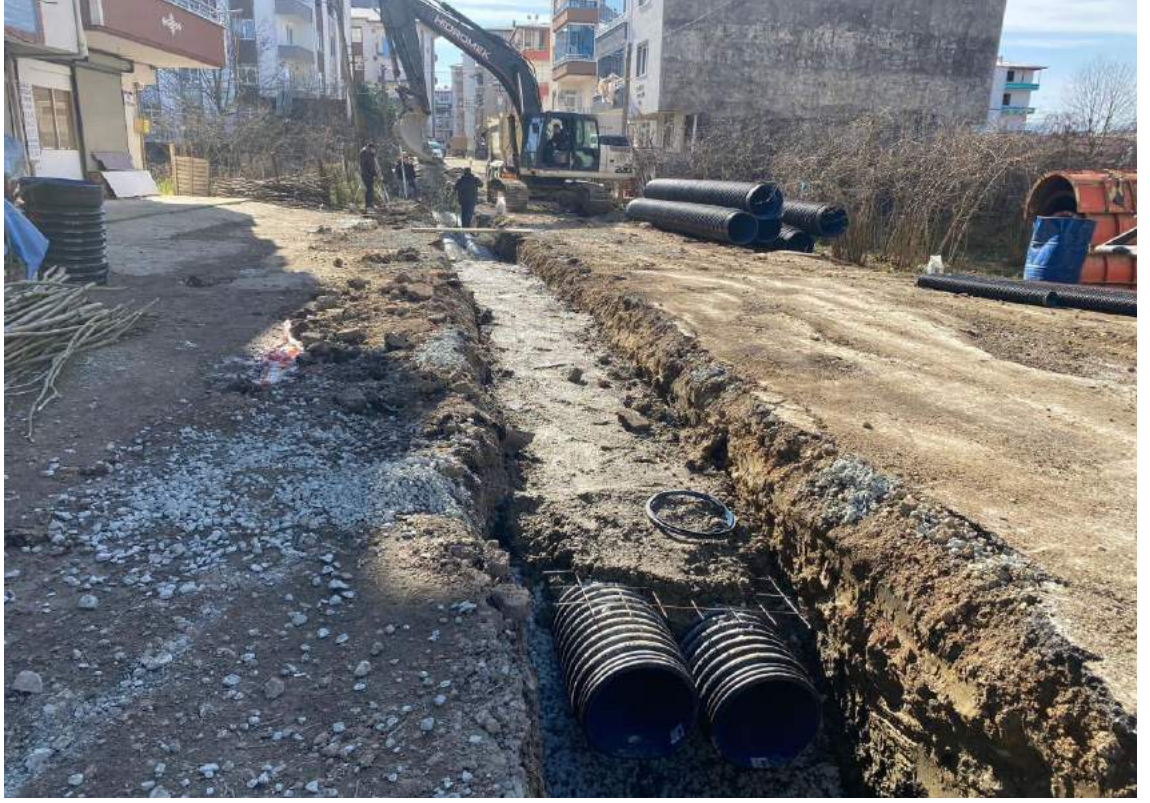
Eskipazar Mahallesi Sayharman Sokak Yağmursuyu Hattı Yapım İşi
