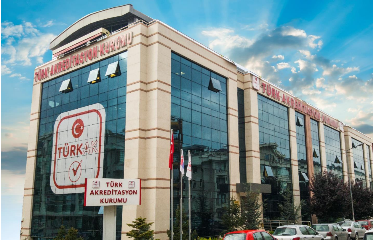
Resim 1: TÜRKAK Hizmet Binası
