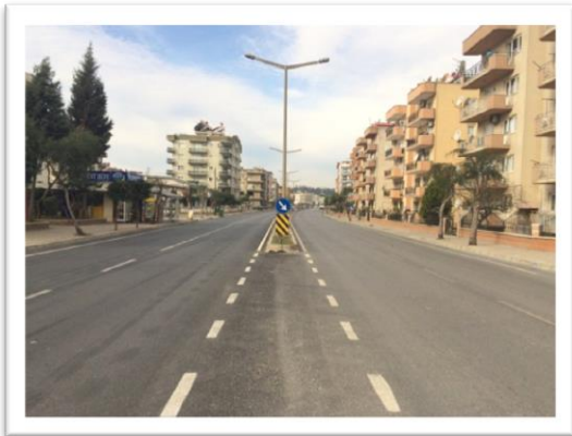
Çevre Bulvarı asfaltlama çalışması
