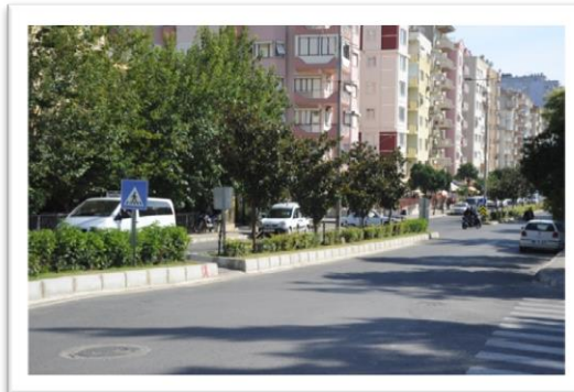
Atatürk Bulvarı asfalt yol çalışması
