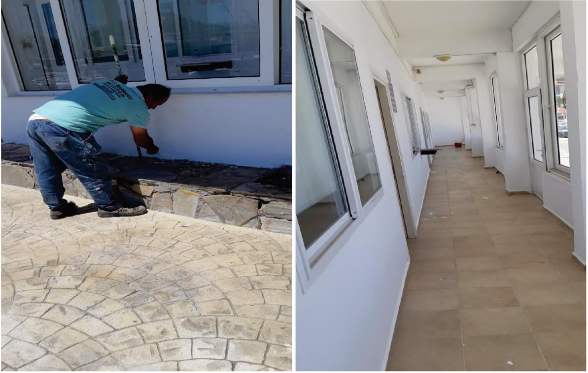
Bozburun mahallesi gümrük binası boyaması yapıldı.
