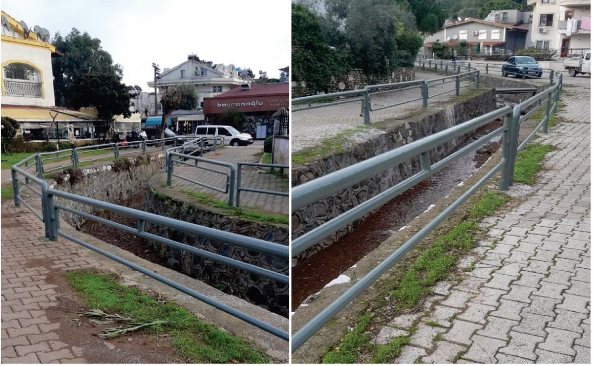
Armutalan mahallesinde bulunan dere korkuluklarının boyanması yapılmıştır.
