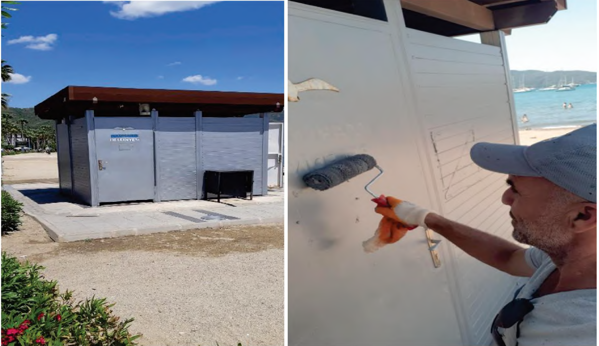
Yaz sezonu öncesi ekiplerimiz halk plajlarında bulunan soyunma kabini ve wc kapılarının boyamalarını tamamladı.
