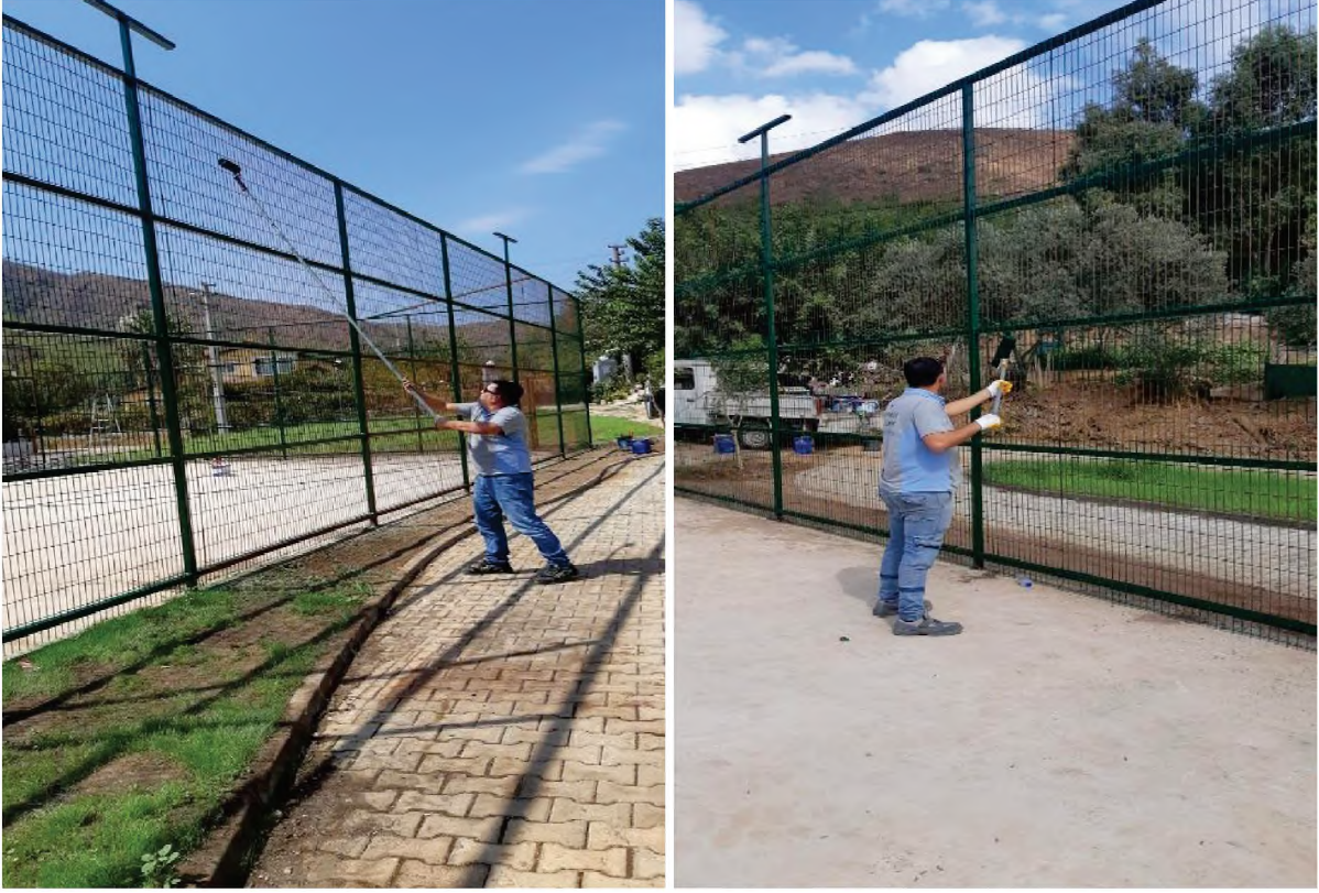
Belediyemiz bünyesinde bulunan spor sahaları ve park etrafında ki demir çitlerin boyama işleri yapıldı.
