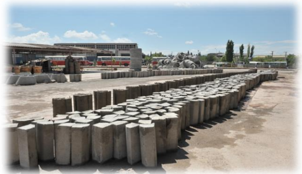
Bordür Üretim Tesisi
