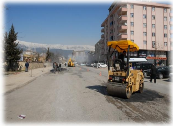
Yama Asfalt Kaplama
