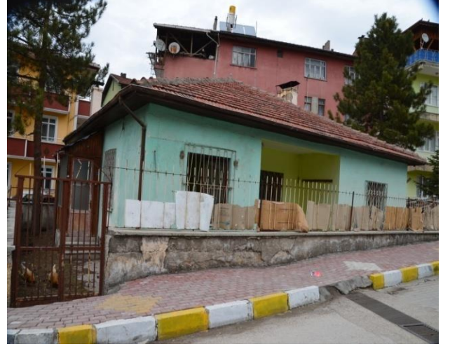
Eski Hizmet Binası
