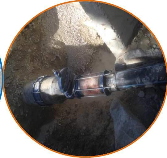
Sanayii Deposu Menfez Geçişi Yenilendi
