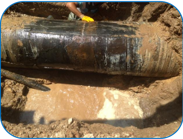
Çatağıl Çelik Boru Tamirâtı
