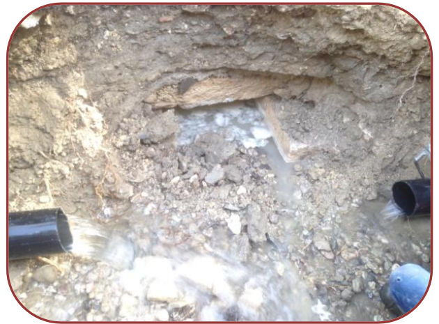
Gazi Camii Önü Eski Örgü Kanala Giden Su
