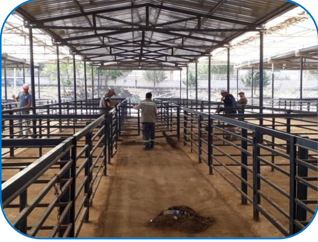
Hayvan Pazarı alanı düzenli olarak temizlenmiştir.
