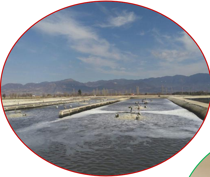
Atık Su Arıtma Tesisi
