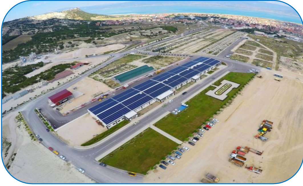
SULTAN DERESİ HİZMET KAMPÜSÜ SAHASINDA ASFALT ÇALIŞMALARI TAMAMLANDI.
