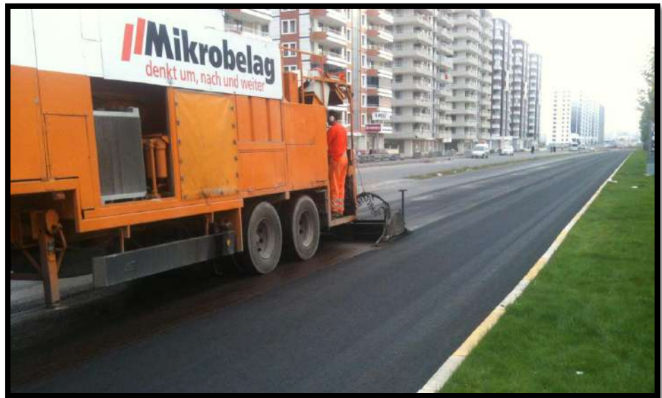
75 metrelik Mahabad Bulvarı Soğuk Asfalt Kaplama Yapılması
