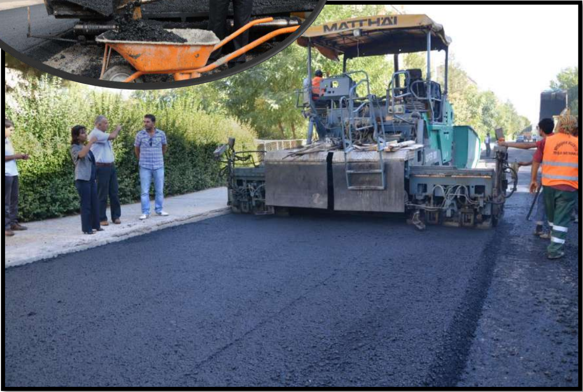
2012 yılında Toplukonut'taki toplu ulaşım yolundaki asfalt çalışması...
