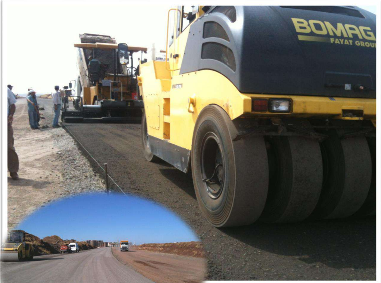
BAĞCILAR-MARDİN YOLU- BAĞIVAR KÖPRÜSÜ BAĞLANTI YOLU (1.KISIM) ÇALIŞMALARI
