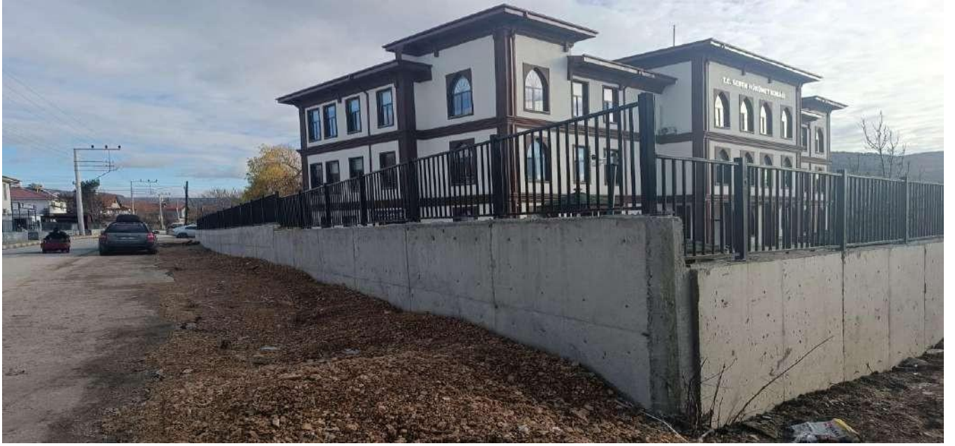
Seben Hükümet Konağı
