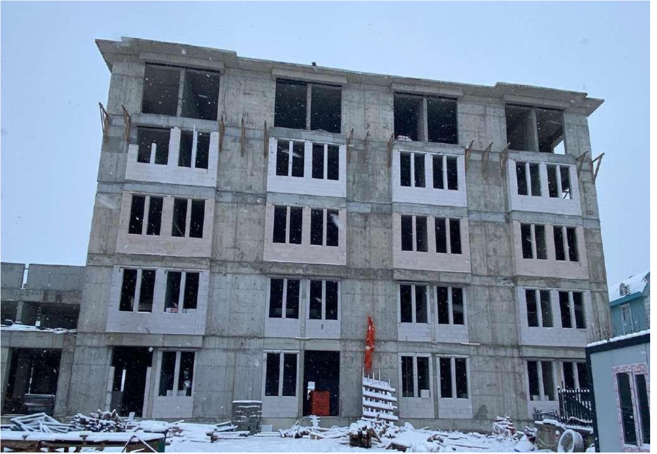
Bolu Merkez Altındağ İHL Pansiyon Binası
