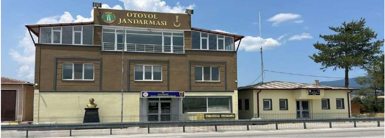
Bolu Aliçören Otoyol Jandarma Karakol Hizmet Binası
