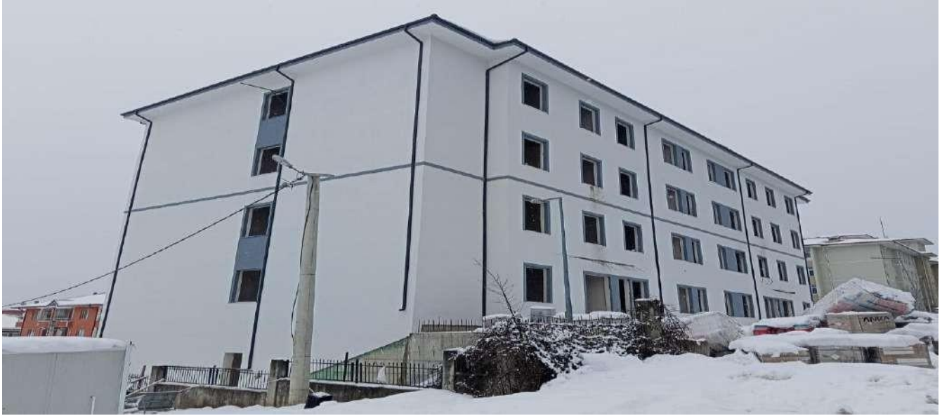
Bolu Mengen MTAL Pansiyon Binası
