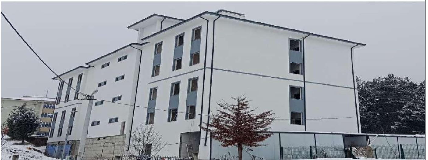
Bolu Mengen MTAL Pansiyon Binası
