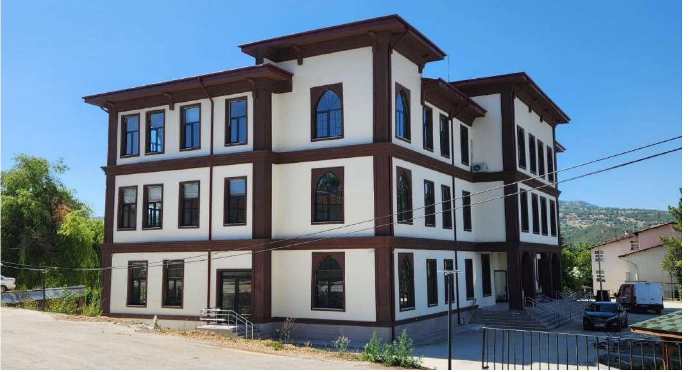
Seben Hükümet Konağı
