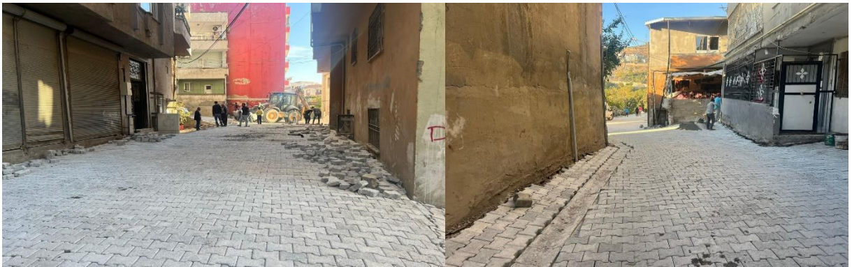
İlimiz Merkez Muhtelif Yerlerde Yol Genişletme Ve Taş Duvar Çalışmaları.
