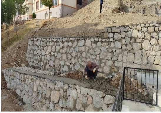
İlimiz Merkez Muhtelif Yerlerde Taş duvar Yapım Çalışmaları.
