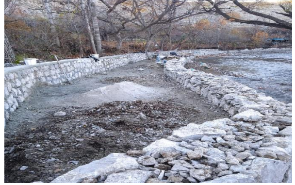
Gühüzok Bölgesi yol genişletme ve taş duvar yapım çalışmaları
