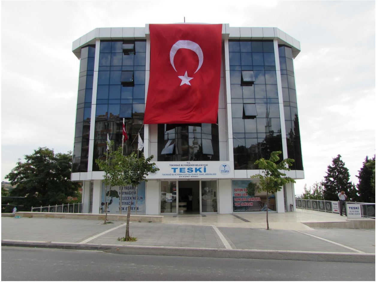
*TESKİ Ek Hizmet Binası
