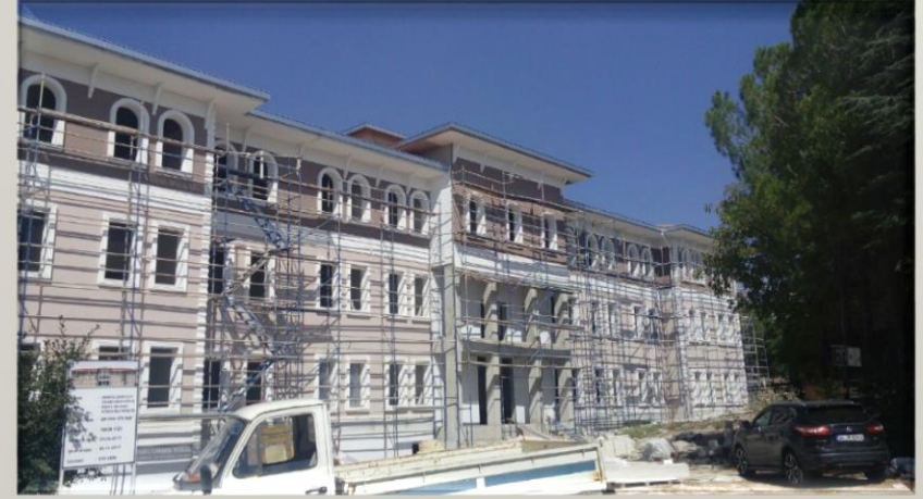
ÇAVDIR HÜKÜMET KONAĞI İNŞAAT FOTOĞRAFI
