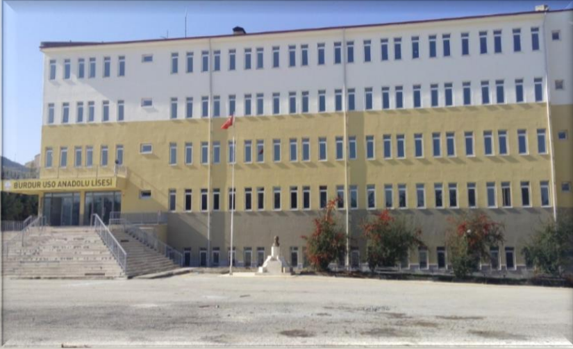
BURDUR MERKEZ USO ANADOLU LİSESİ DEPREM GÜÇLENDİRME ÇALIŞMALARIMIZ
