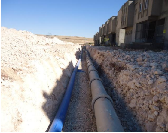
Hat İmalatlarından Görünüm
