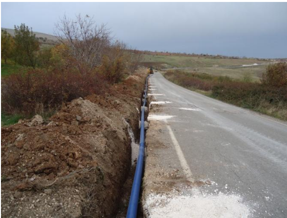
İçmesuyu Hattı Çalışması
