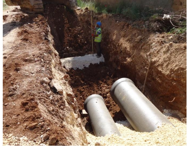
Hat Döşeme Çalışması
