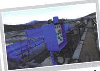
Ön Çökeltim Havuzlarından ek ünite zincir sıyrıcı sistemi değiştirilerek doğrusal sıyrıcı köprü sistemi şeklinde dönüştürüldü.
