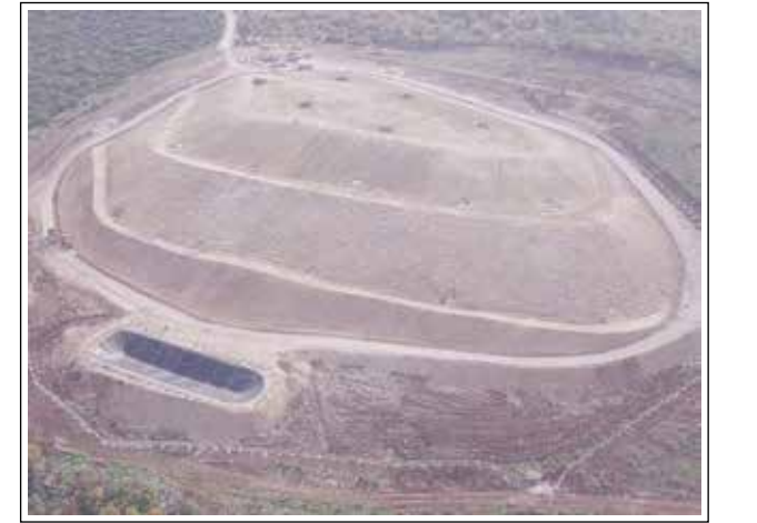
Gönen İlçesi Vahşi Depolama Sahasının Rehabilitasyon Sonrasındaki Görüntüsü
