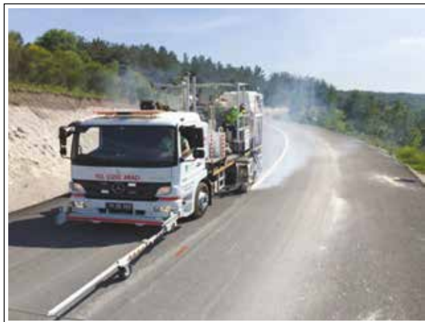
Pamukçu-Türkali Termoplastik Yol Çizgi Çalışması
