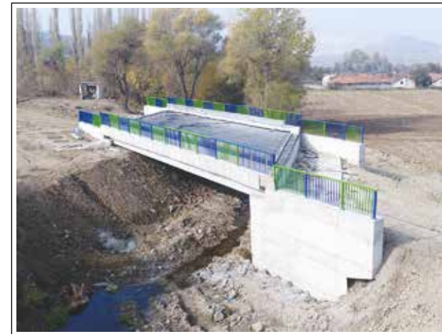
Bigadiç Salmanlı Dere Köprüsü Yapım İşİ
