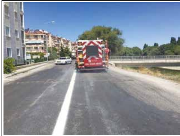
Zeytinli Caddesi Yol Çizgi Çalışması
