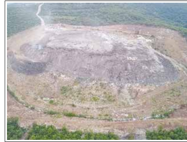
Gönen İlçesi Vahşi Depolama Sahasının Rehabilitasyon Öncesindeki Görüntüsü
