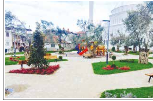
Havran Temaşalık Mahallesi Park Yapımı
