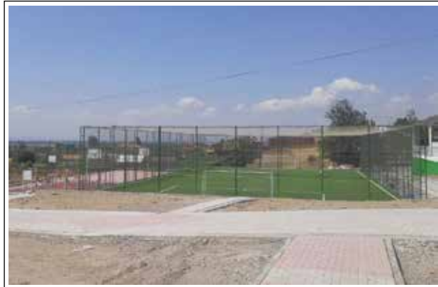
Kepsut Hotaşlar Mahallesi Park Yapımı
