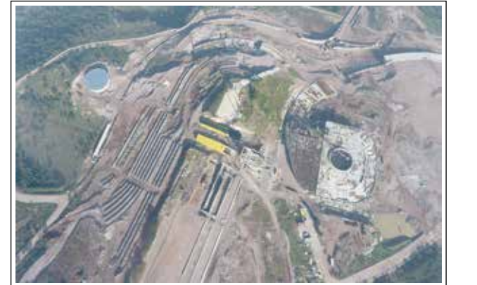
Çamlık Tepesi Rekreasyon Alan Yapım İşi
