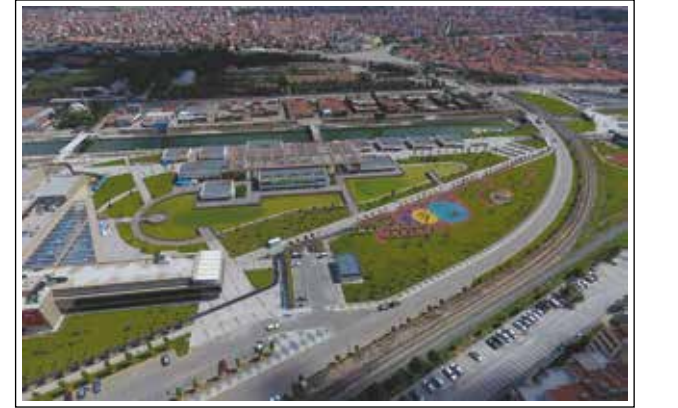
Çay Deresi Rekreasyon Alanı 1.Etap Yapım İnşaatı İşi
