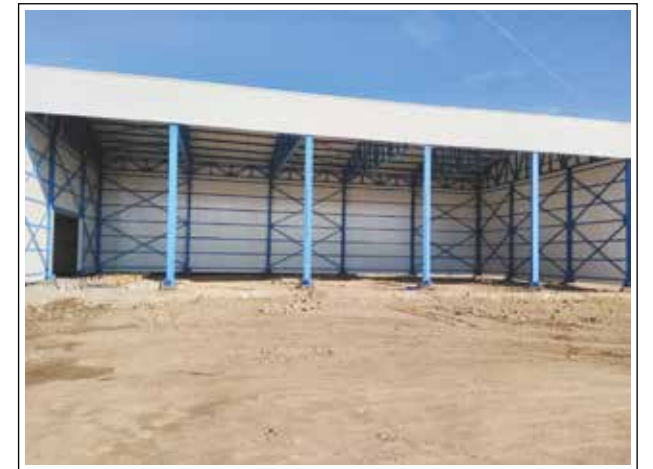
Kepsut ve Havran İtfaiye Garajı
