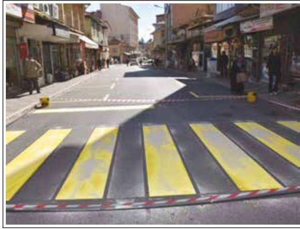
Dursunbey Mahalle Yolu Levha ve Çizgi Çalışması
