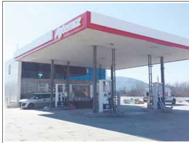
Gayri Sihhi Müessese görüntülerinden (Gaz Dolum Tesisi)
