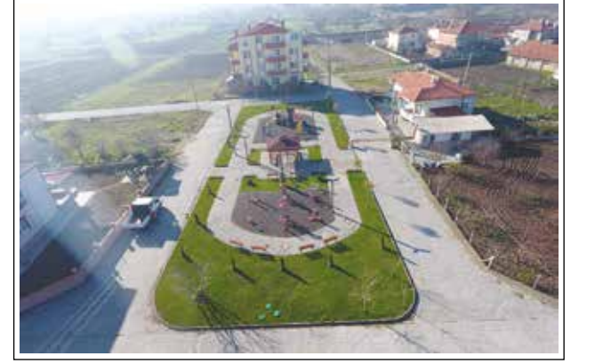
Bigadiç 4 Eylül Mahallesi Park Yapımı
