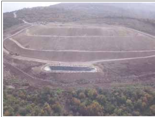
Gönen Rehabilitasyon Sahası
