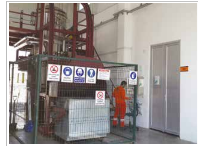
Tıbbi Atık Sterilizasyon Tesisi
