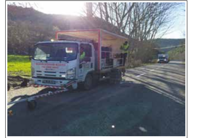
Çayüstü Mahallesi Yol Çizgi Çalışması
