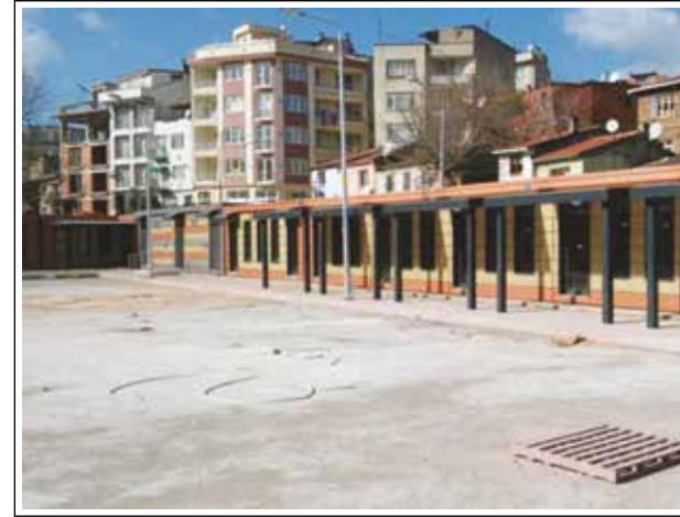
Prefabrik Yeni Otobüs Terminali
