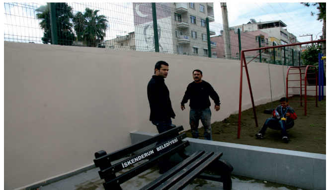
Okullara ihata duvarı ve tel çit yapılması
