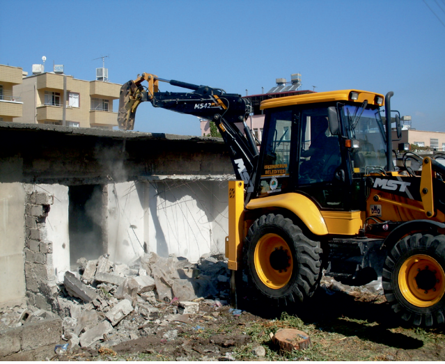
Sakarya Mahallesi yeni yol açılması
