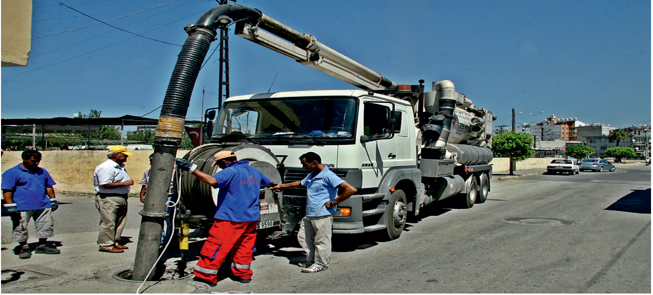
Kombi klavuz aracı ile kanalizasyon bacası temizliği
