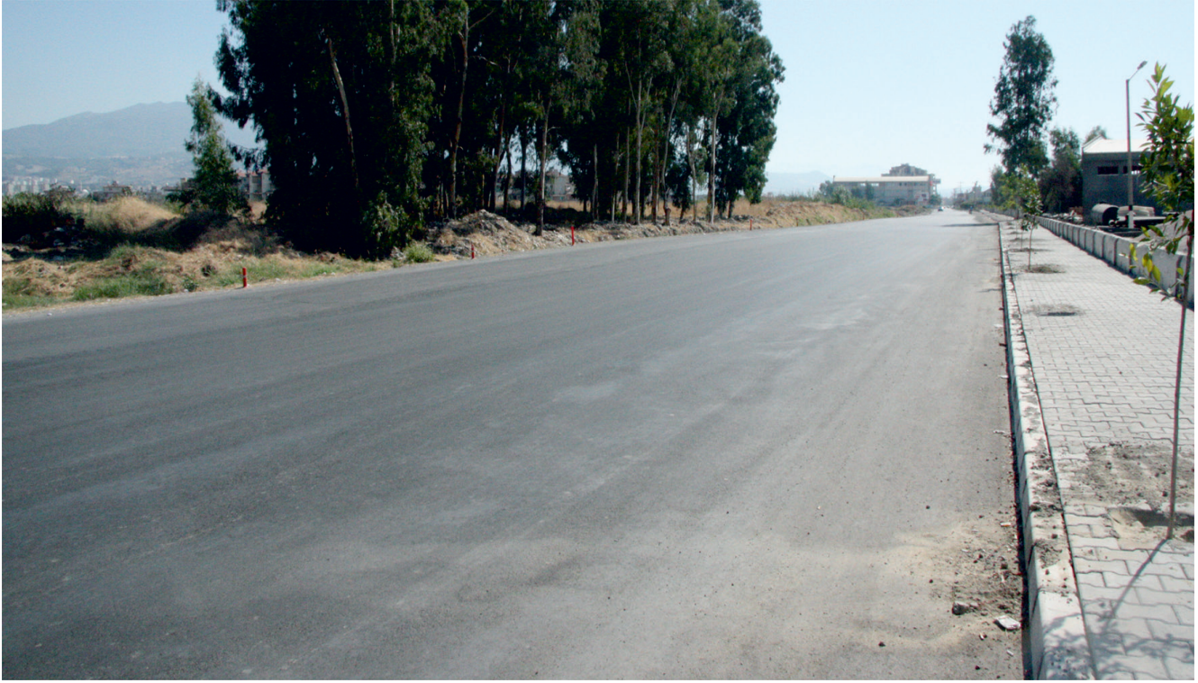
İkem Koleji yeni yol asfalt yapımı çalışması tamamlandı
