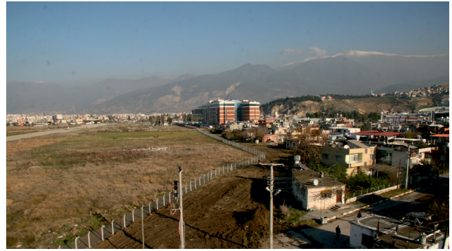
Gürsel Mahallesi yeni yol açılması
