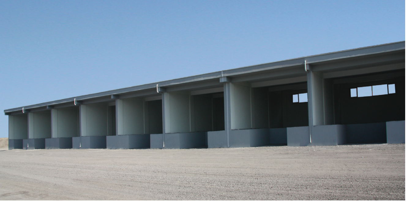
Yeni Tüp Deposu
