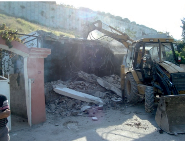
Modernevler Mahallesi kaçak inşaat yıkımı
