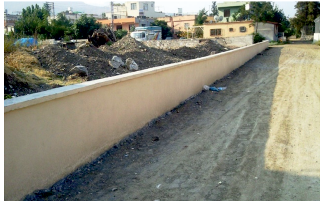
Modernevler 298 sokak briketten parapet duvar yapılması
