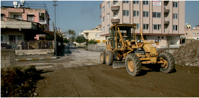
İsmet İnönü Mahallesi yeni yol açılması çalışmaları
