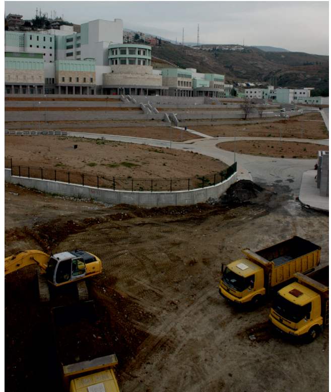
Yeni Devlet Hastanesi yol yapım çalışması
