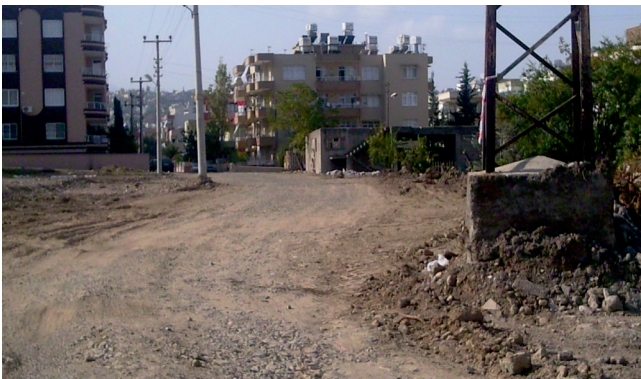
Sakarya Mahallesi yeni yol açılması
