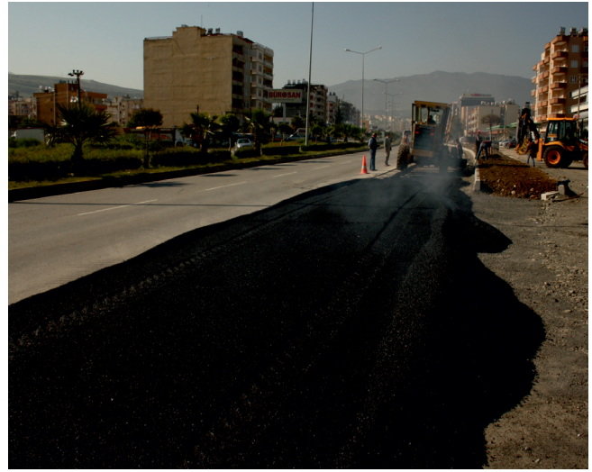
Asfalt yol kaplama yapılması
