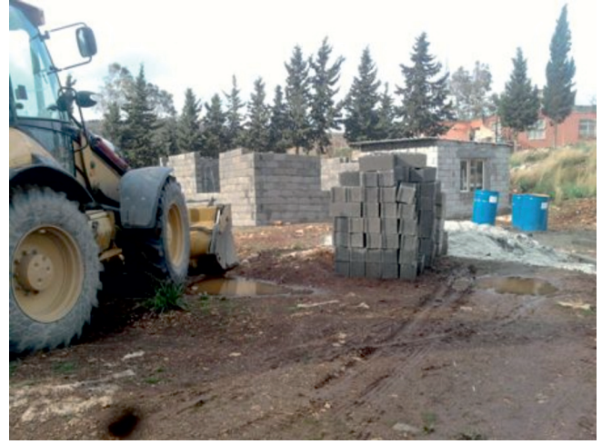
Buluttepe Mahallesi kaçak inşaat yıkımı
