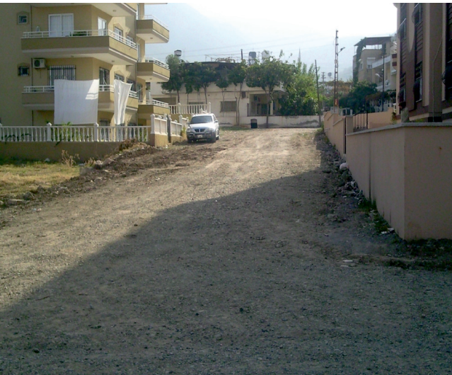
Sakarya Mahallesi yeni yol açılması
