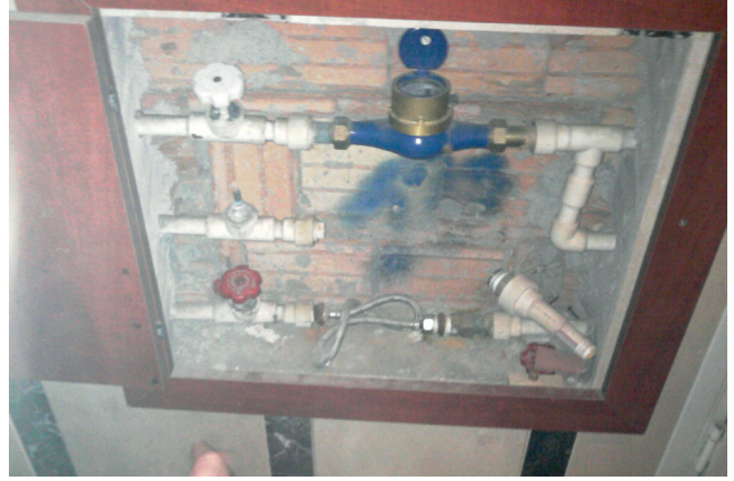
Kaçak su bağlantısı
