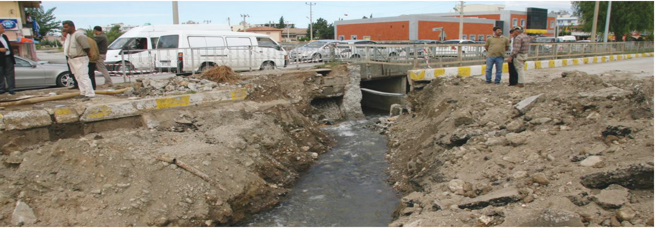
E-91 Karayolu yağmursuyu menfez inşaatı
