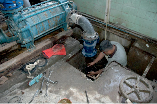
Su terfi pompa istasyonlarının tamir, bakım ve onarımları yapıldı.
