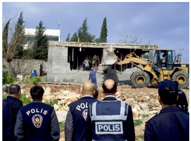
Buluttepe Mahallesi kaçak inşaat yıkımı
