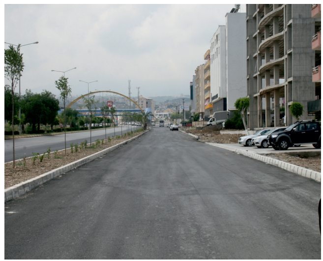
Asfalt yol kaplama yapılması
