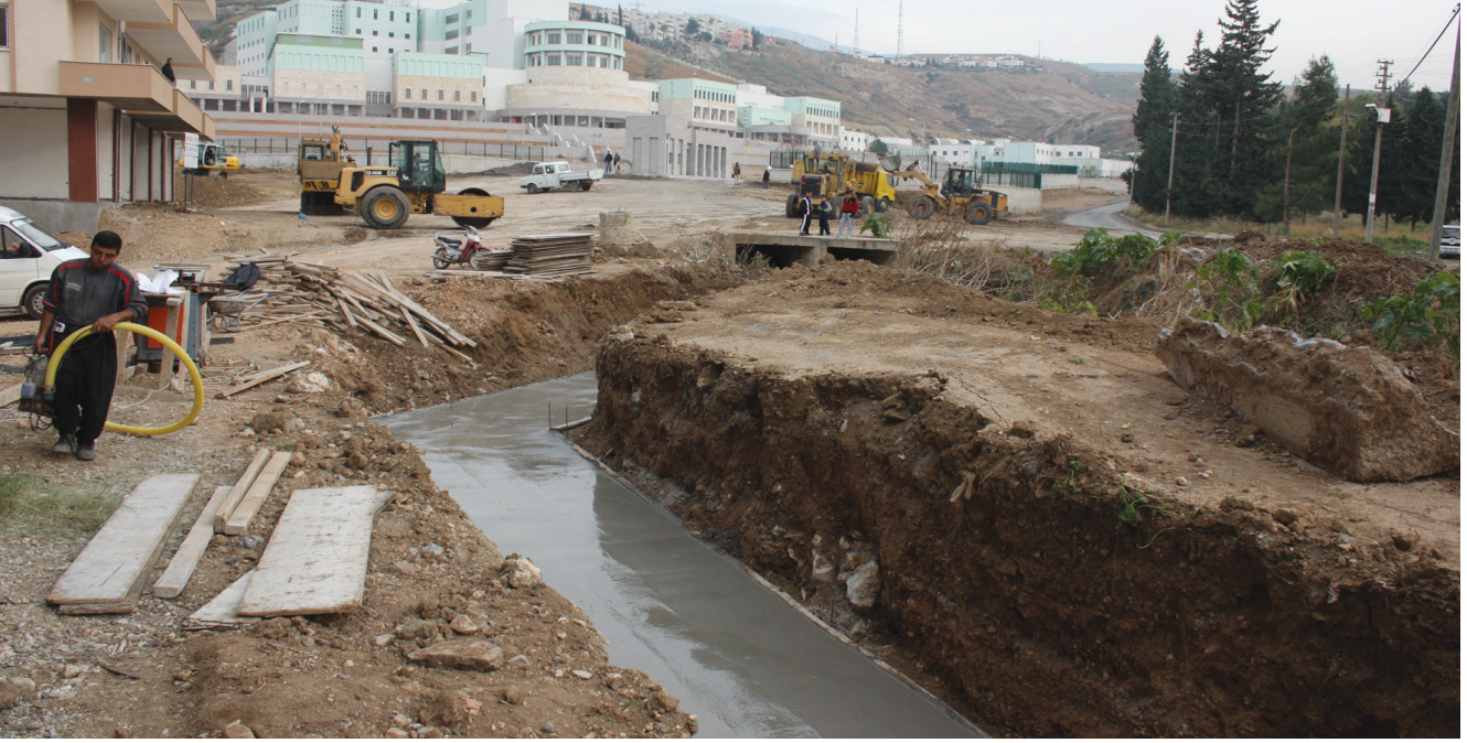
Dr.Sadık Ahmet Caddesi Yeni Devlet Hastanesi yağmur suyu menfez inşaatı
