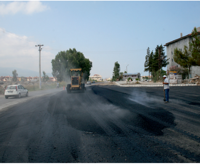
Asfalt yol kaplama yapılması
