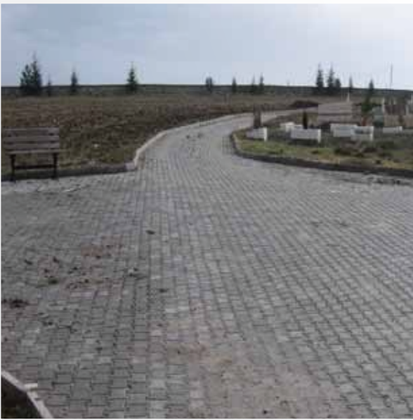
Tulumtaş Mahallesi Beton Parke Döşeme Çalışmaları
