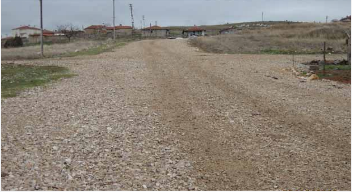
Oğulbey Mahallesi Yol Yapım Çalışmaları
