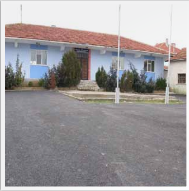
Gökçehöyük Mahallesi Asfaltlama Çalışmaları
