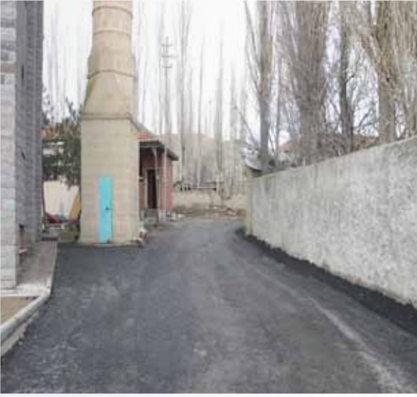
Bağıcı Mahallesi Asfaltlama Çalışmaları
