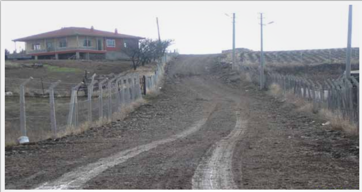
Selametli Mahallesi Yol Yapım Çalışmaları
