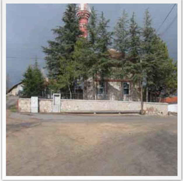
Günalan Mahallesi Asfaltlama Çalışmaları
