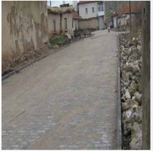
Velihimmetli Mahallesi Beton Parke Döşeme Çalışmaları
