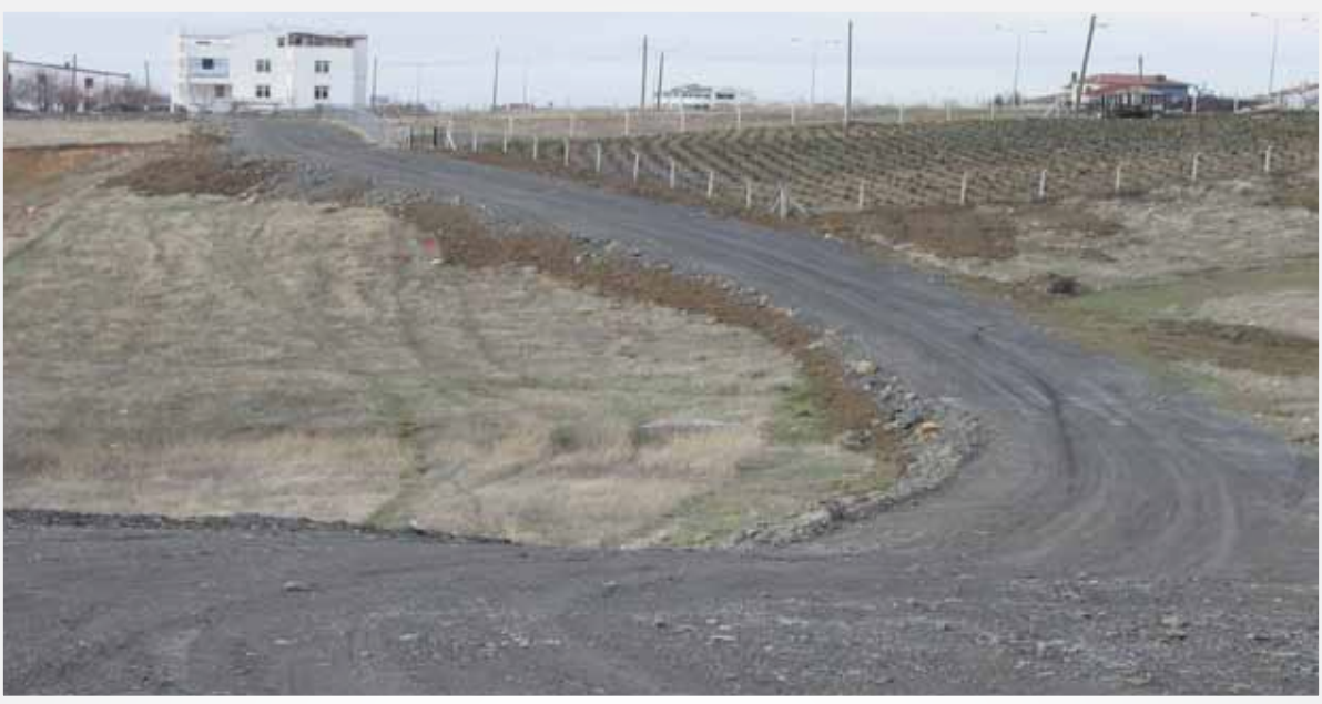
Taşpınar Mahallesi Yol Yapımı Çalışmaları
