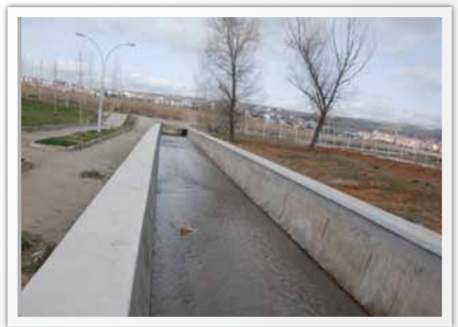
Sahil Parkı Kanal Yapım İşİ
