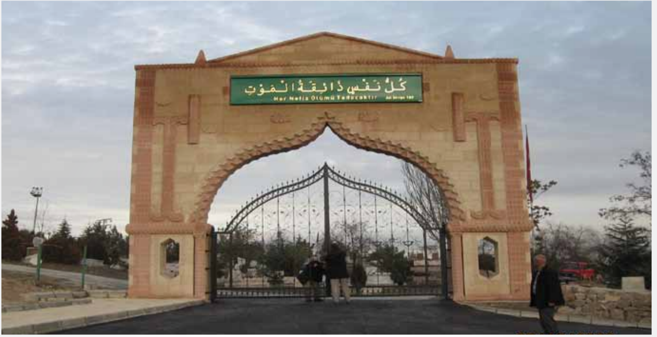
İlçe Mezarlığımızda Yapılan Asfaltlama Çalışmaları
