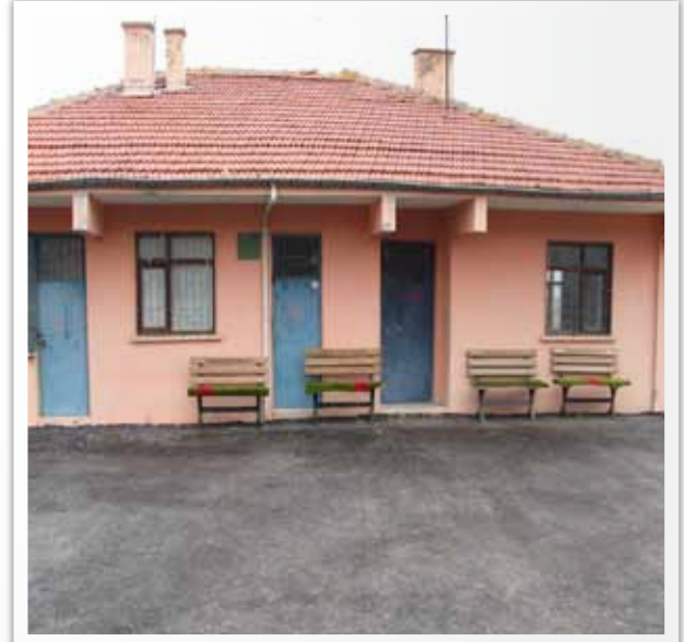
Koparan Mahallesi Asfaltlama Çalışmaları
