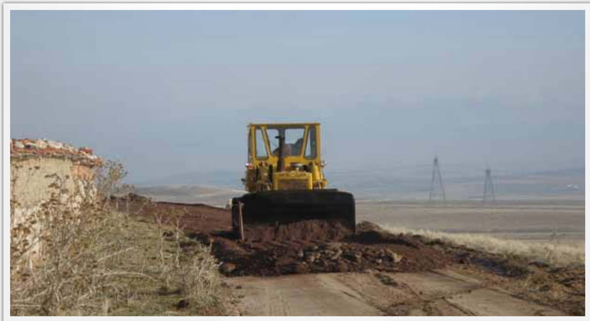
Oyaca Mahallesi Yol Açım Çalışmaları
