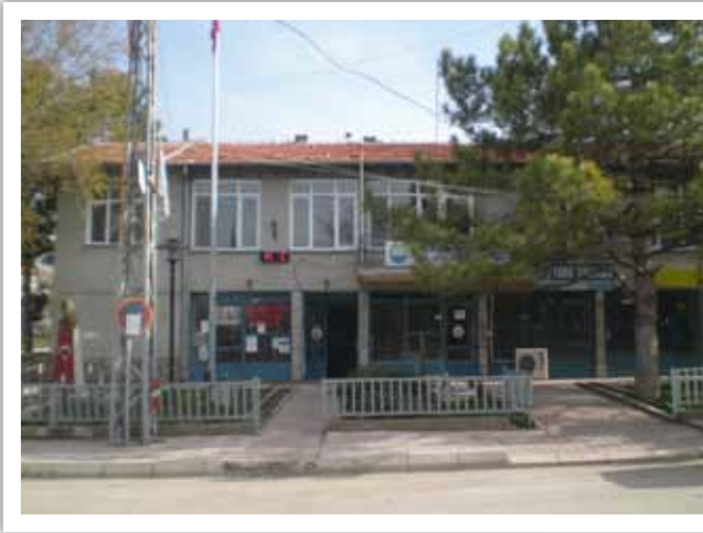
Oyaca Mahallesi Ek Bina
