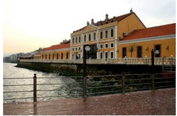
Fotoğraf: Montania Hotel (Gar Binası)
