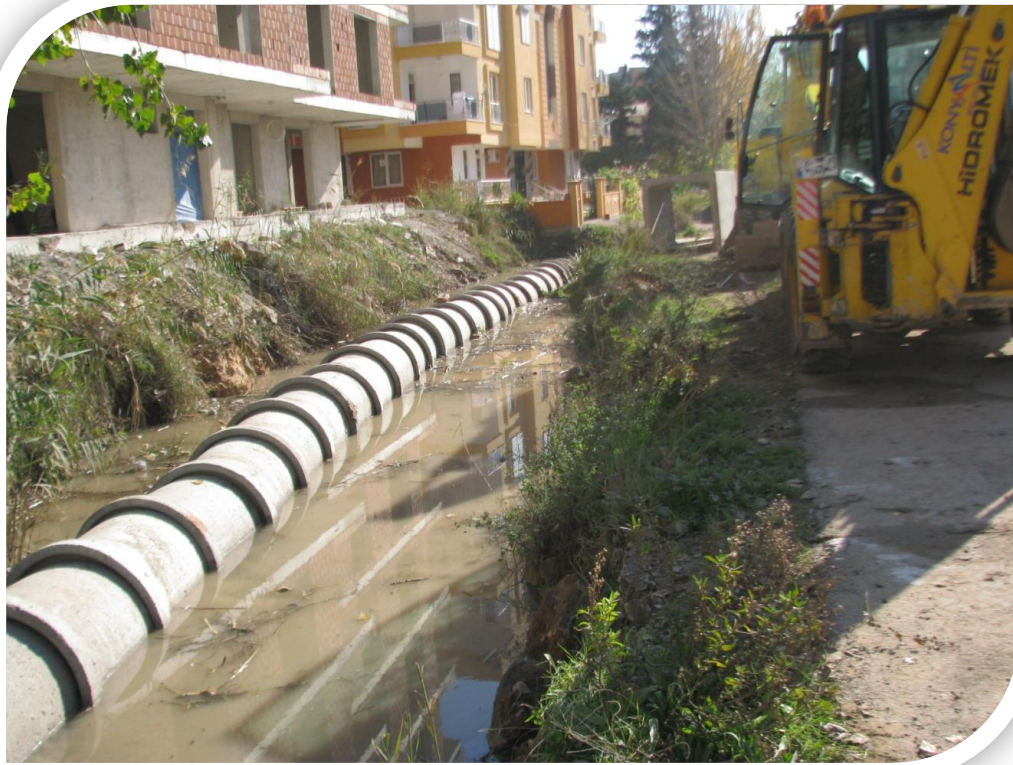
Hurma Mahallesi 271. Sokak Drenaj Çalışması
