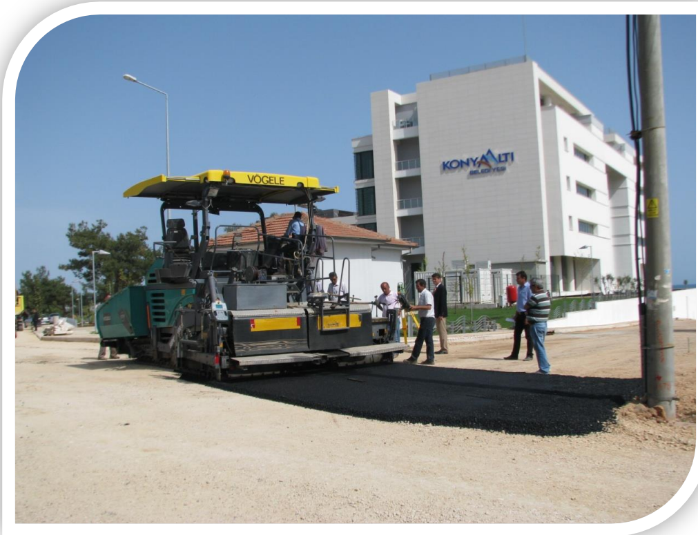
Kuşkavağı Mahallesi 500. Sokak Asfalt Çalışması
