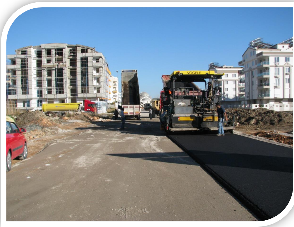
Hurma Mahallesi 272. Sokak Asfalt Yapım Çalışması
