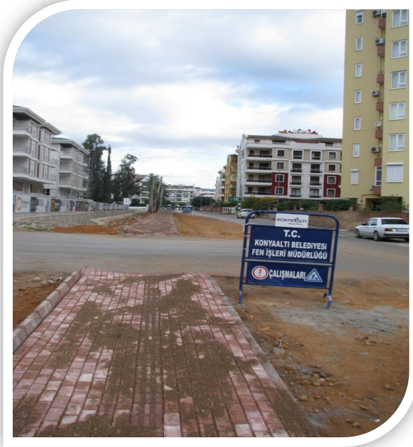
Gürsu Mahallesi 353 Sk ve Uluç Mahallesi 1155 Sk Kaldırım Yapım Çalışmaları.
