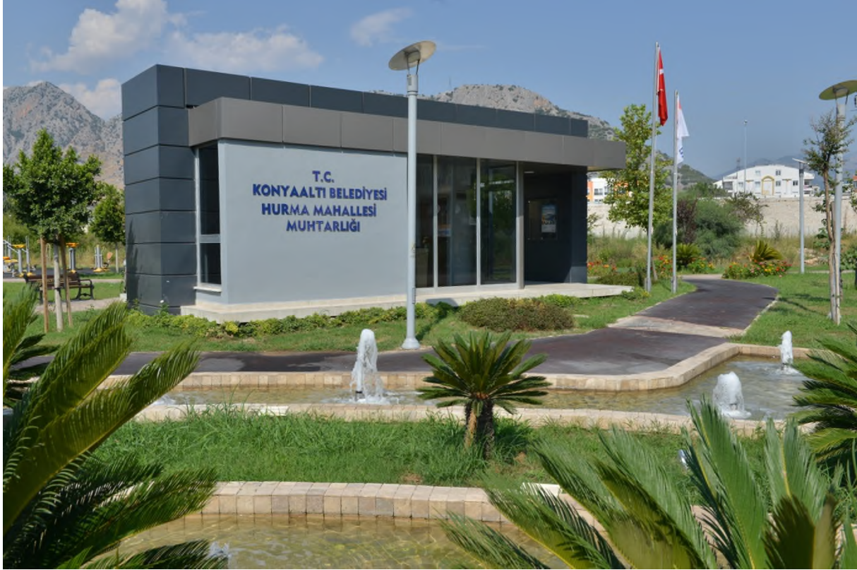
Görsel 9 : Hurma Muhtarlık Binası
