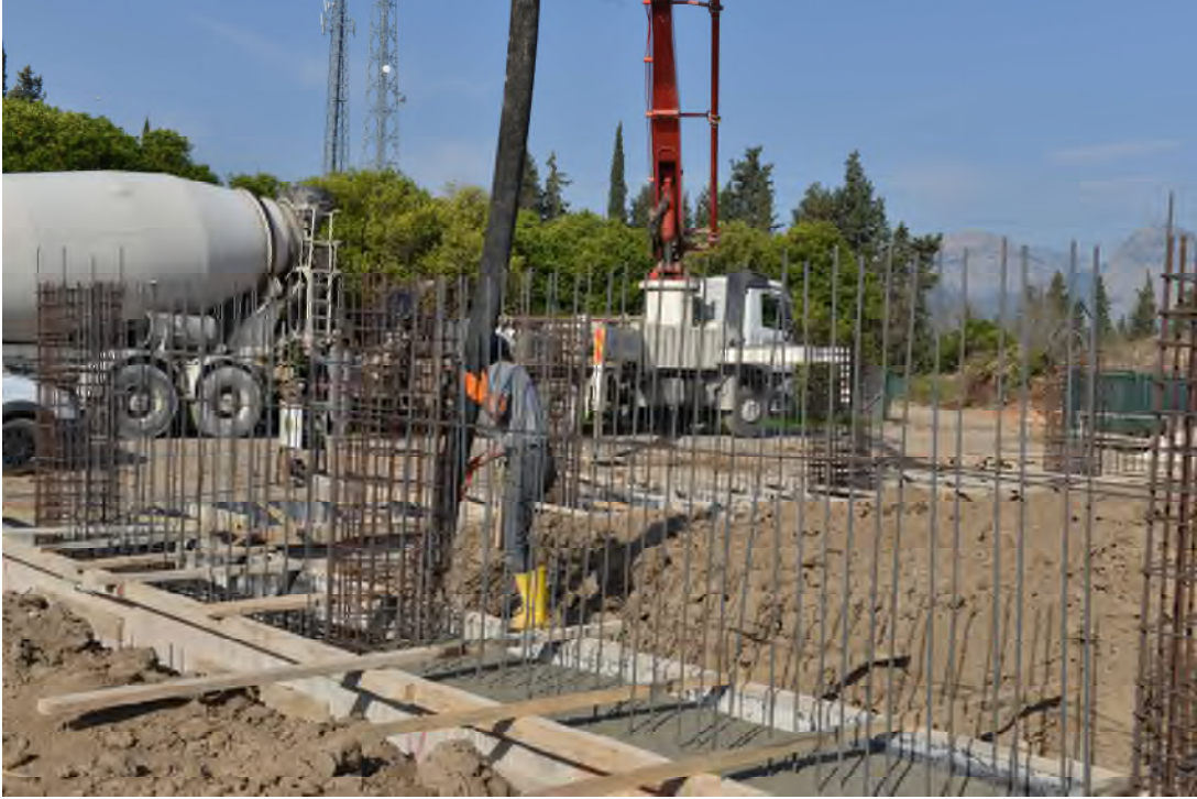
Atık getirme merkezi şantiyesi
