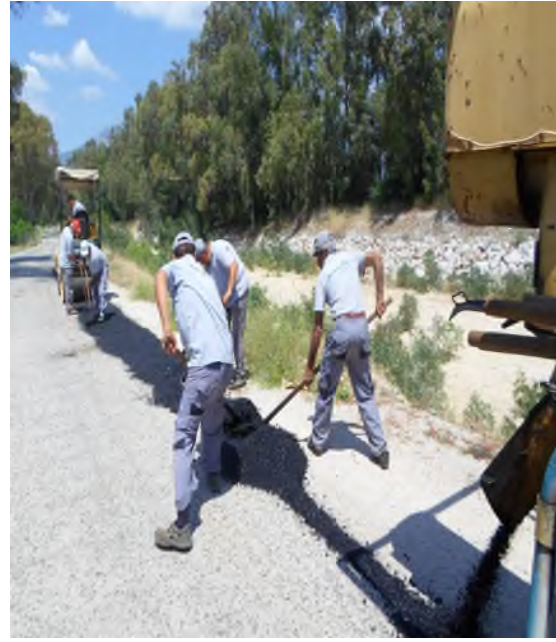
Kuruçay mahallesi Gül sokak Yama Çalışması
