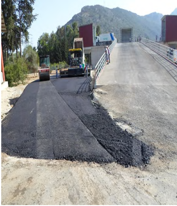
Temizlik işleri şantiyesi
