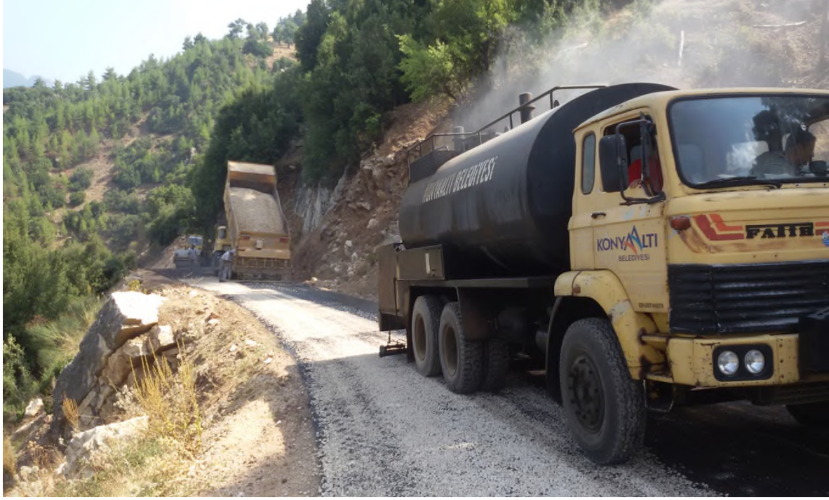
Kökez-França Yolu Sathi Kaplama Çalışması
