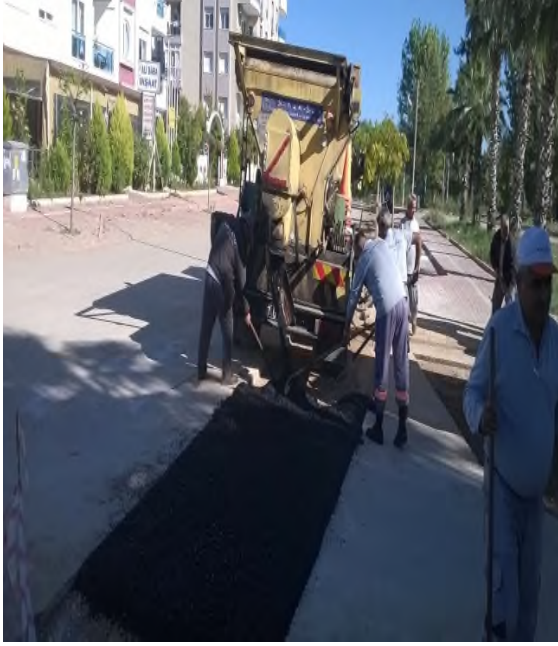
Liman Mahallesi 13 sokak Yama Çalışması
