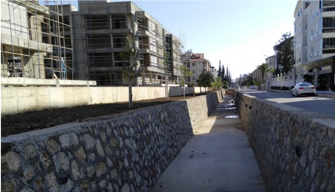
1285 Sokak Taş Duvar Çalışması
