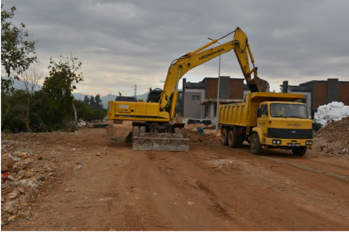
Mollayusuf Mahallesi (Karamersin Mevkii) Ham Yol Açma Çalışması
