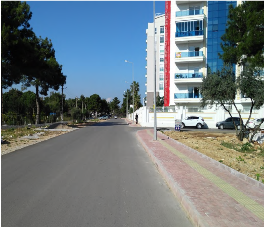
Mollayusuf Mahallesi 1409 Sokak Asfalt Çalışması
