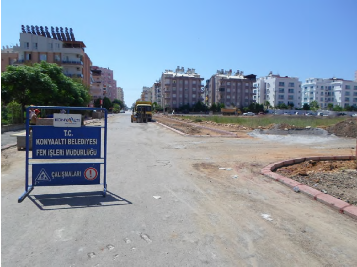
Hurma mahallesi 236 sokak kaldırım çalışması
