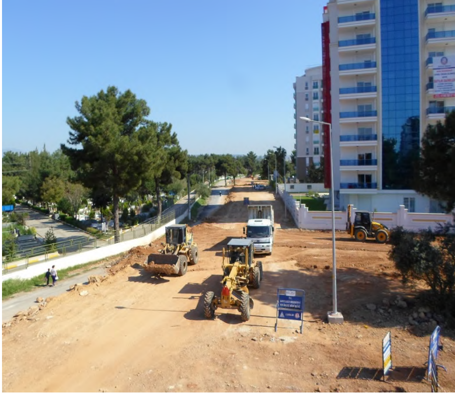
Mollayusuf Mahallesi 1409 Sokak Asfalt Çalışması
