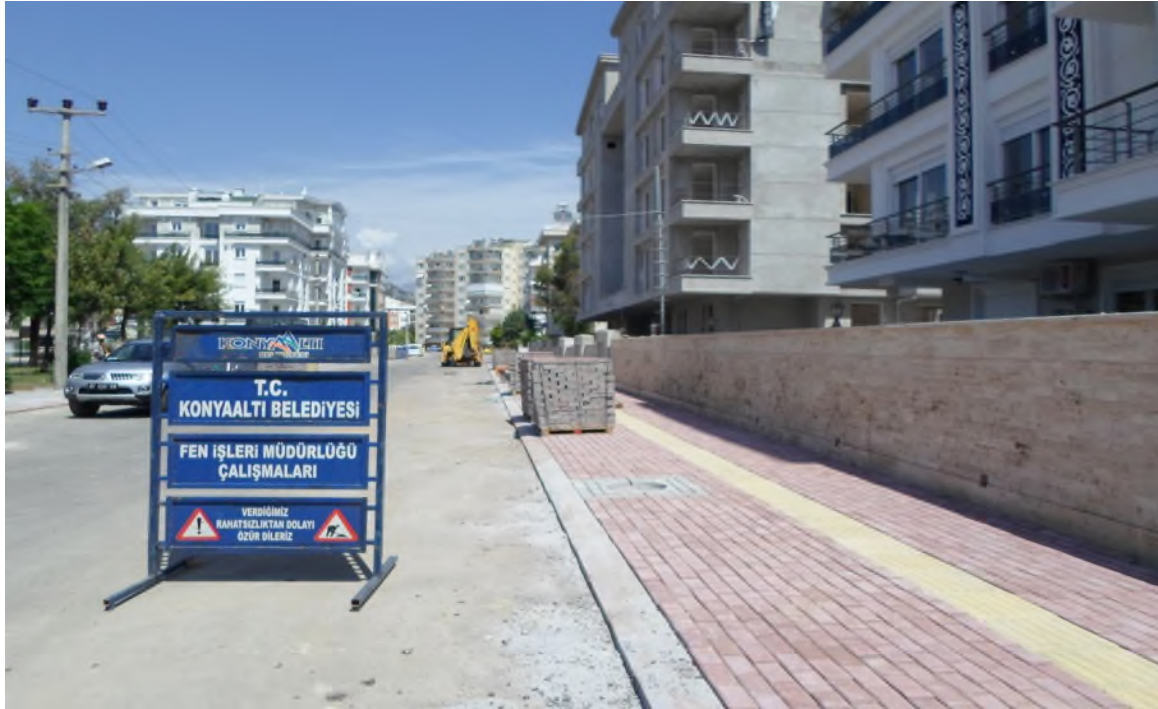
Liman Mahallesi 36 sk kaldırım çalışması
