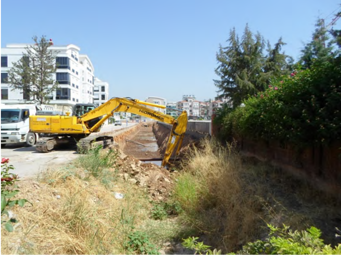
1285 Sokak Taş Duvar Çalışması
