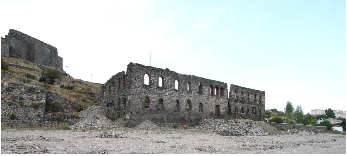
Kars Merkez Beylerbeyi Sarayı Restorasyonu
