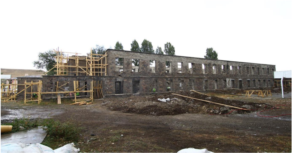
Susuz Hükümet Konağı Restorasyonu
