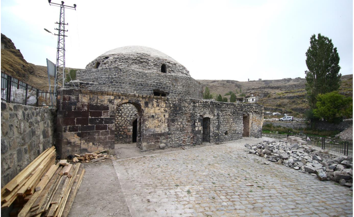
Kars Merkez Mazlum Ağa Hamamı Restorasyonu
