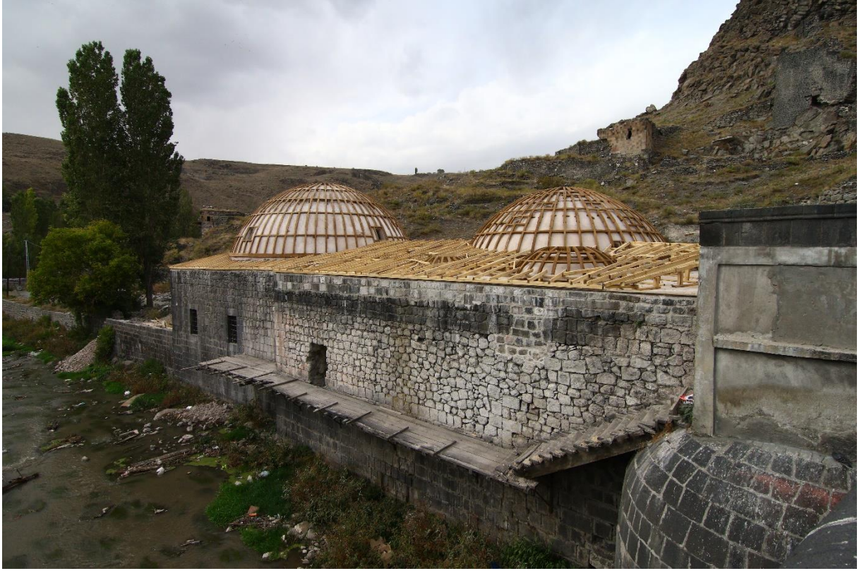
Kars Merkez Muradiye Hamamı Restorasyonu
