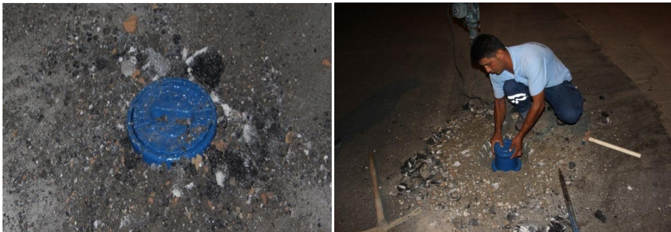
Vana Tespit ve Yenileme Çalışmaları
