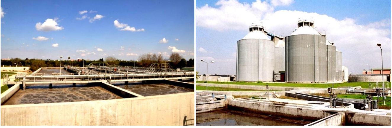
Yüreğir Atıksu Arıtma Tesisi
