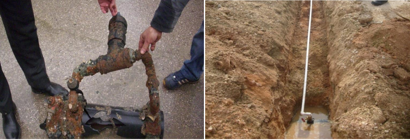
Galvanizli Abone Bağlantısı Yenileme Çalışması
