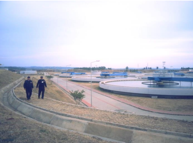
Çatalan İçme Suyu Arıtma
