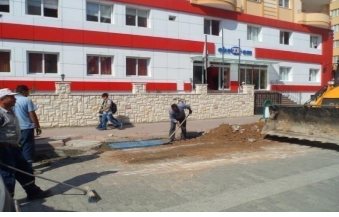
Yağmursuyu Izgara Yapım Çalışmaları
