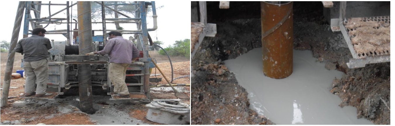
İçmesuyu Sondaj Çalışmaları
