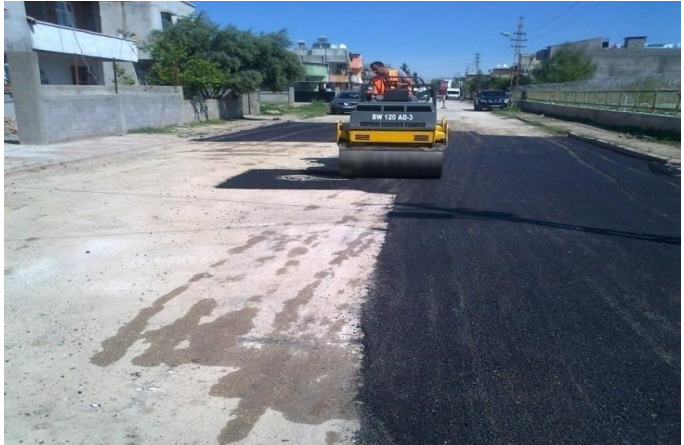
Asfalt kaplama Çalışması
