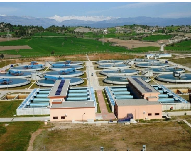
Çatalan İçmesuyu Arıtma Tesisleri
