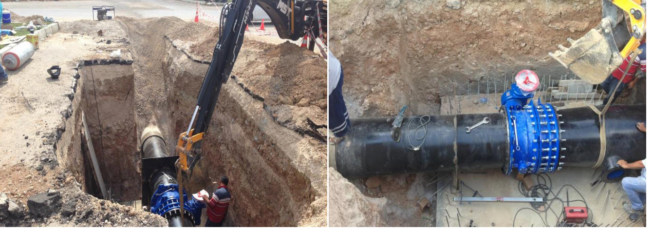
Vana Odası Yapım Çalışmaları
