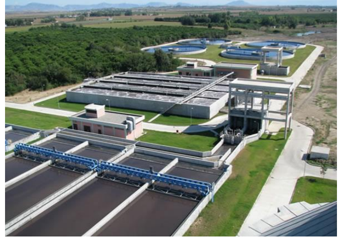
Yüreğir Atıksu Arıtma Tesisleri
