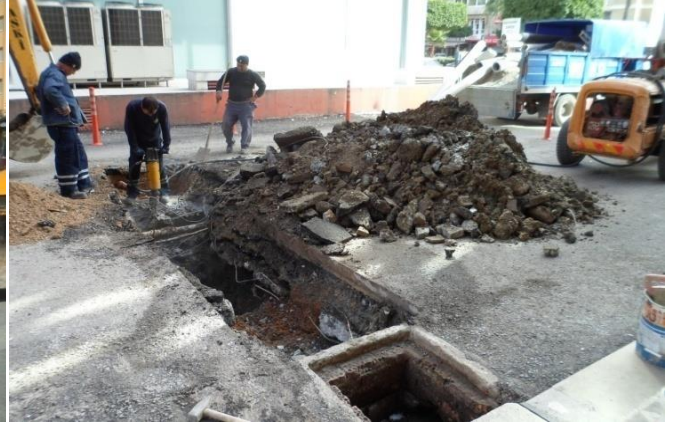
Yağmursuyu Izgara Yapım Çalışmaları
