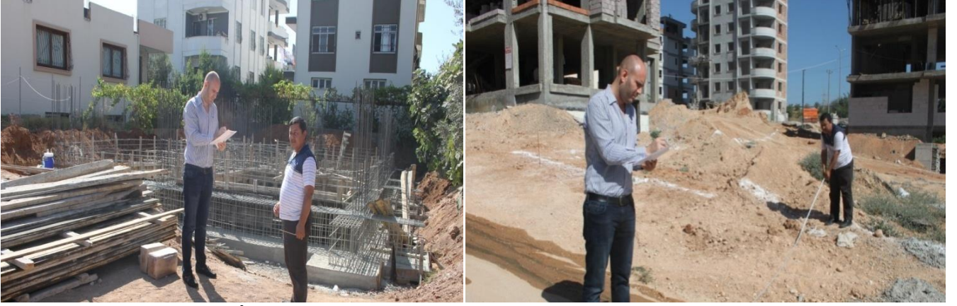
İlk Abonelik tesisi ile ilgili keşif ve tespit çalışmaları
