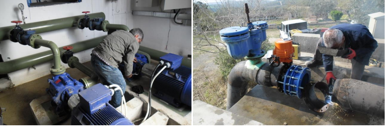
Pompa Sistemleri Bakım ve Onarım Çalışmaları
