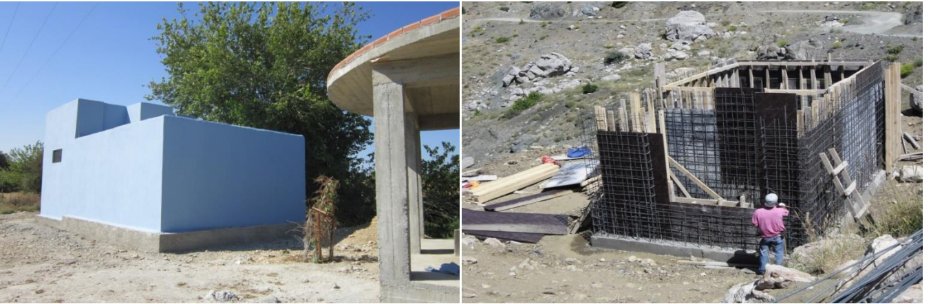
Pompa ve Terfi İstasyonu Yapım ve Onarım Çalışması
