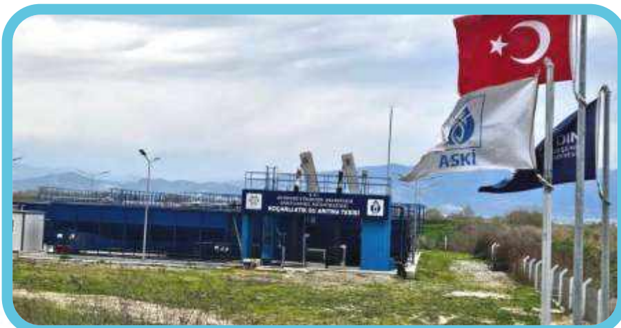
Koçarlı Atık Su Arıtma Tesisi
