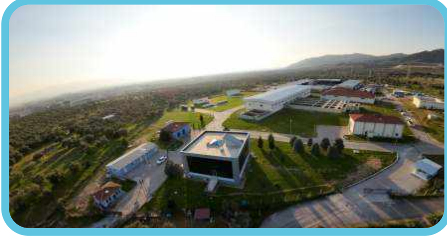
Balıkköy İçme Suyu Arıtma Tesisi
