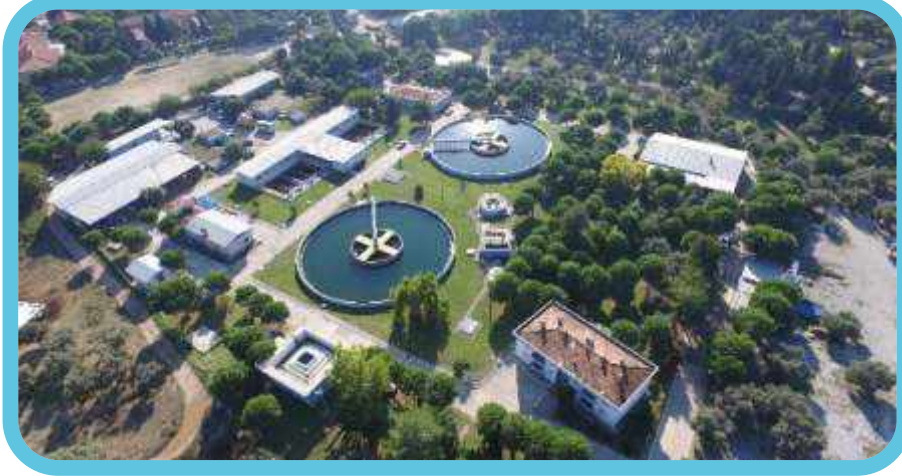
Topyatağı İçme Suyu Arıtma Tesisi
