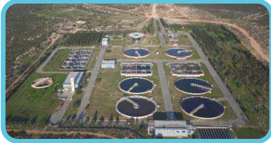
Didim Atık Su Arıtma Tesisi
