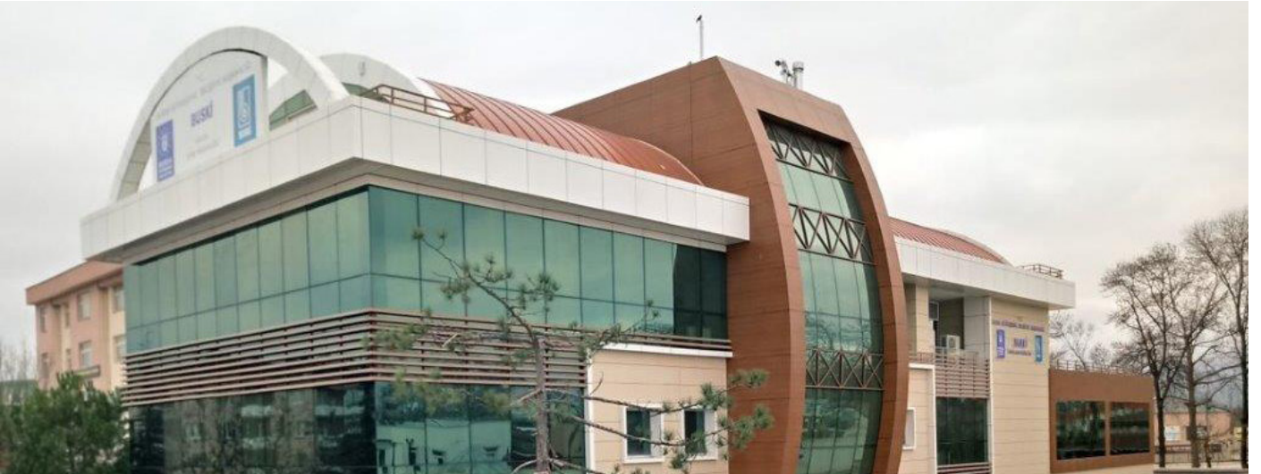
İnegöl Hizmet Binası
