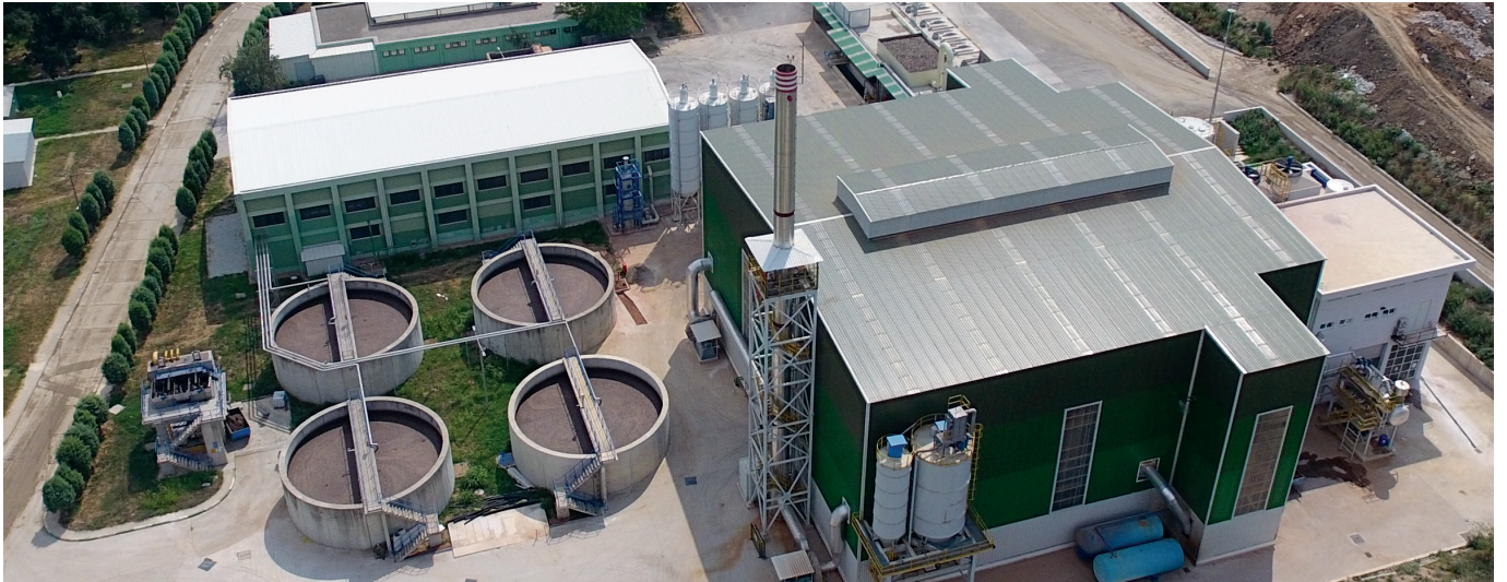
Çamur Yakma Sonucu Elde Edilen Elektrik Enerjisi 1.800 (kw/saat)
