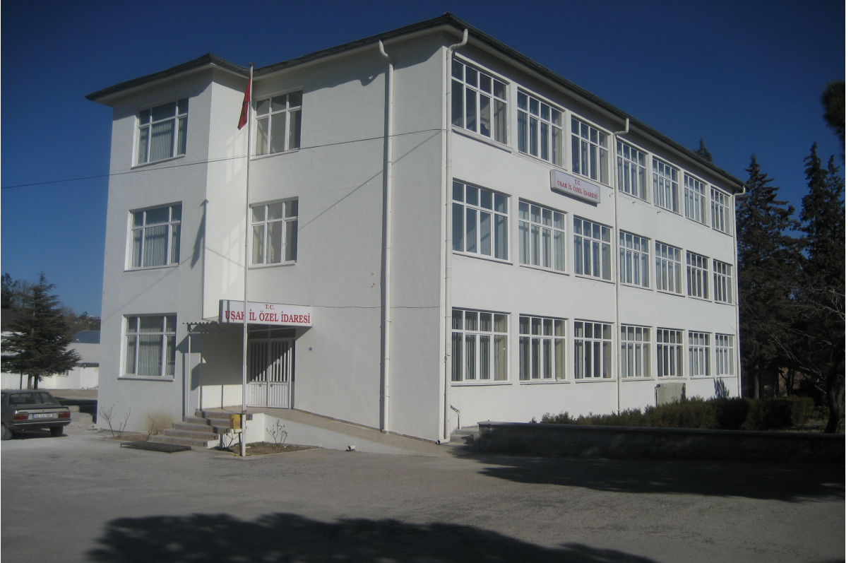
B Blok Hizmet Binası;
