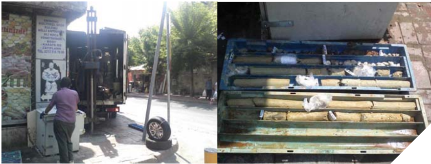
Yerinde kontrolü yapılan Sondaj çalışmaları (Nişanca Mehmetpaşa Sokak)
