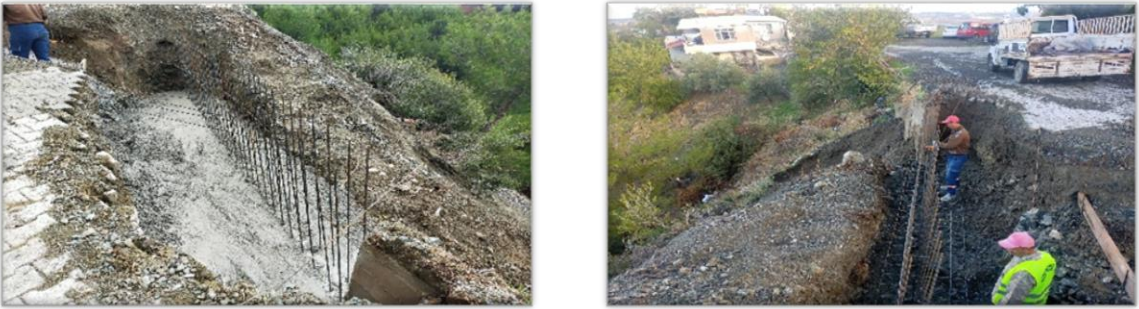
Görsel 17 İstinat Duvar Yapımı
