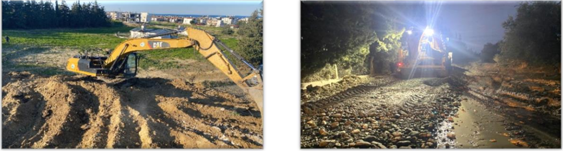
Görsel 19 Yol Yapımı
