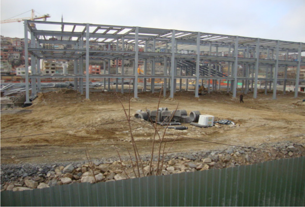
Resim: Geçici Kampüs inşaatından bir görünüm.
