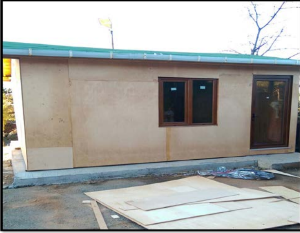
Baklacı Kuran Kursu dış cephesine 36 m 2 ahşap kaplama yapımından görseller.
