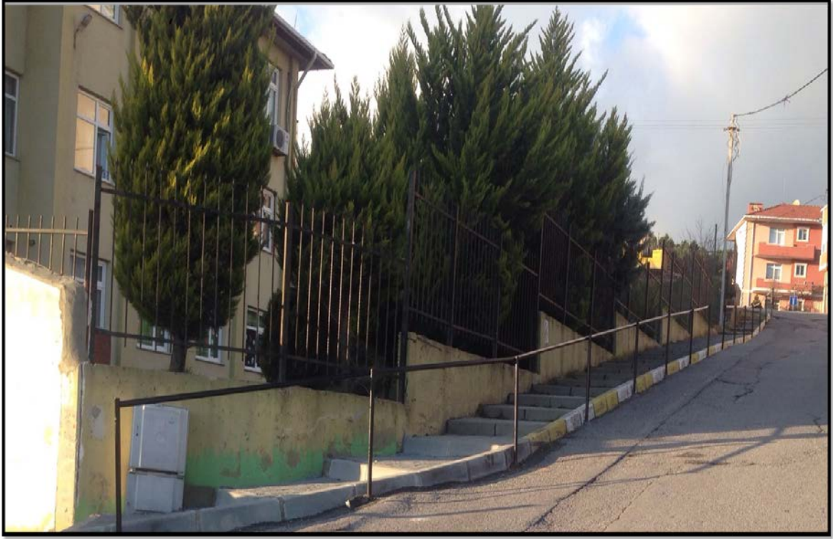
Çengeldere Nene Hatun İlkokulunun merdivenlerine 38 m tutmalık yapılmıştır.
