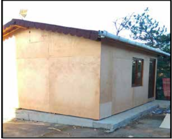
Baklacı Kuran Kursu dış cephesine 36 m 2 ahşap kaplama yapımından görseller.
