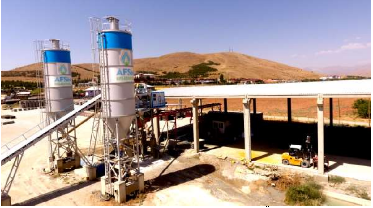
-Afşin'e Kazandırdığımız Beton Elemanları Üretim Tesisi-
