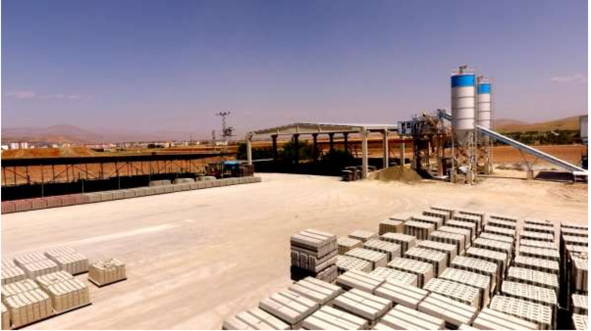
-Afşin'e Kazandırdığımız Beton Elemanları Üretim Tesisi-
