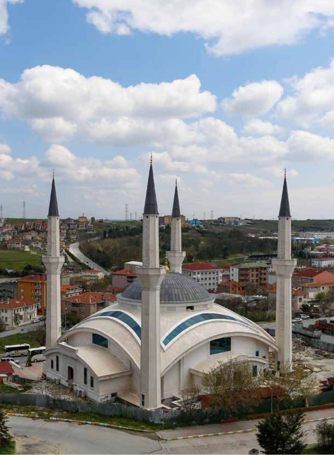
Hadimköy Merkez Camii
