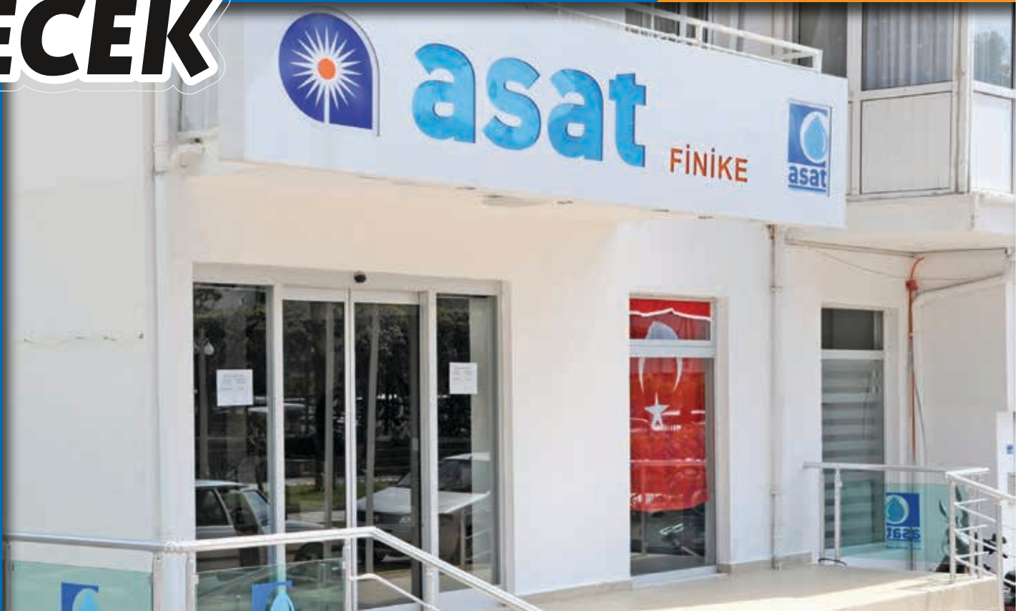
Finike Hizmet Binası
