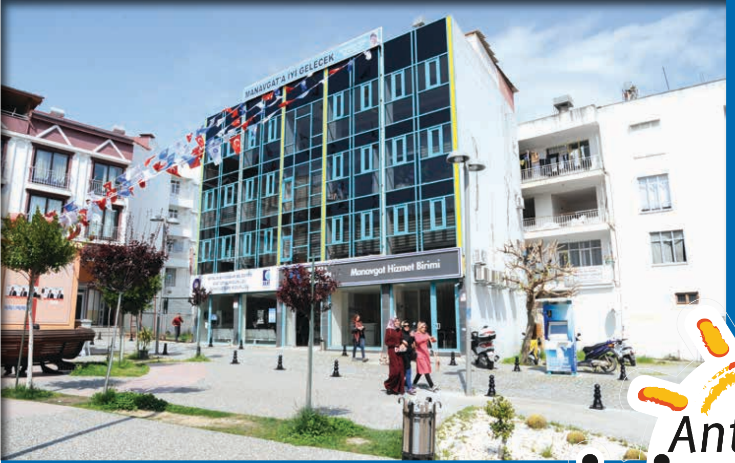
Manavgat Hizmet Binası
