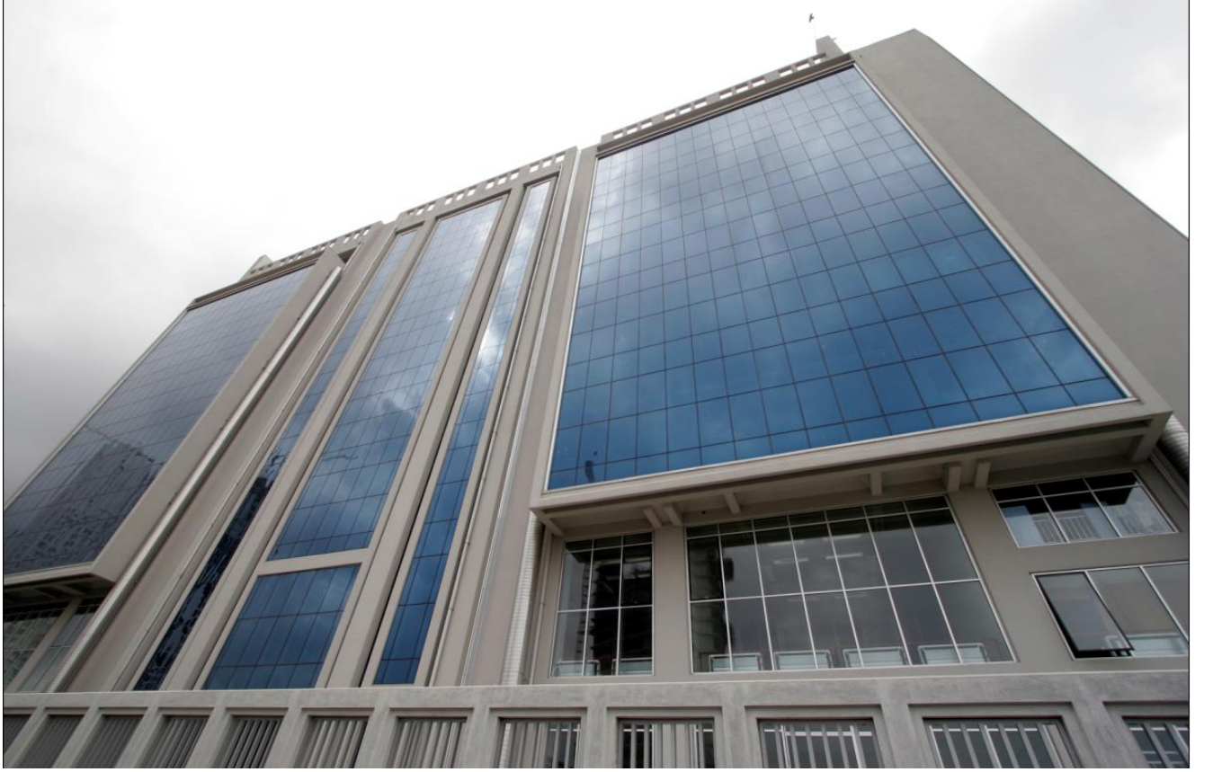
Bomonti kampüs inşaatı dış cephe görünüşü
