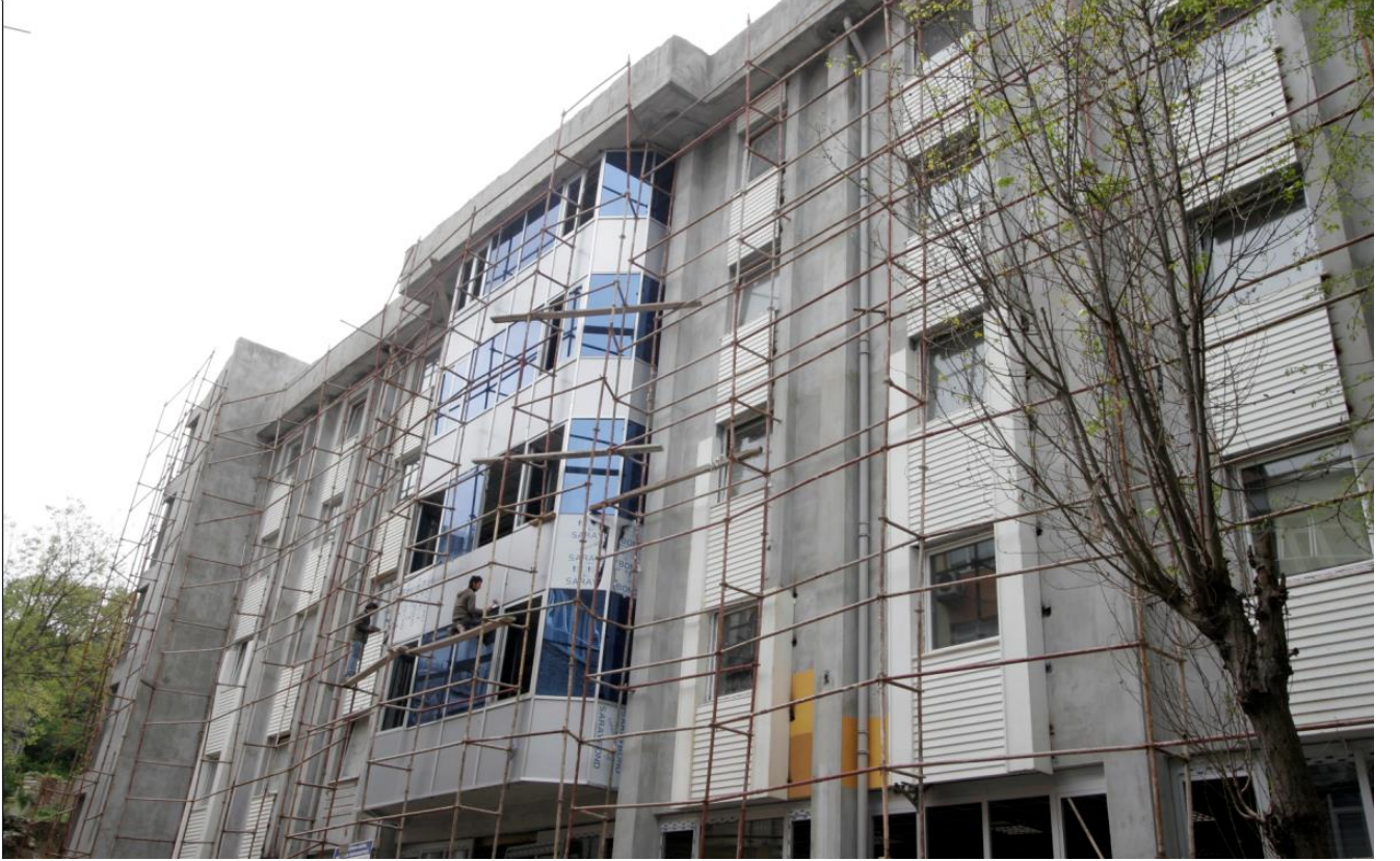
Ortaköy yurt inşaatı dış cephe görünüş
