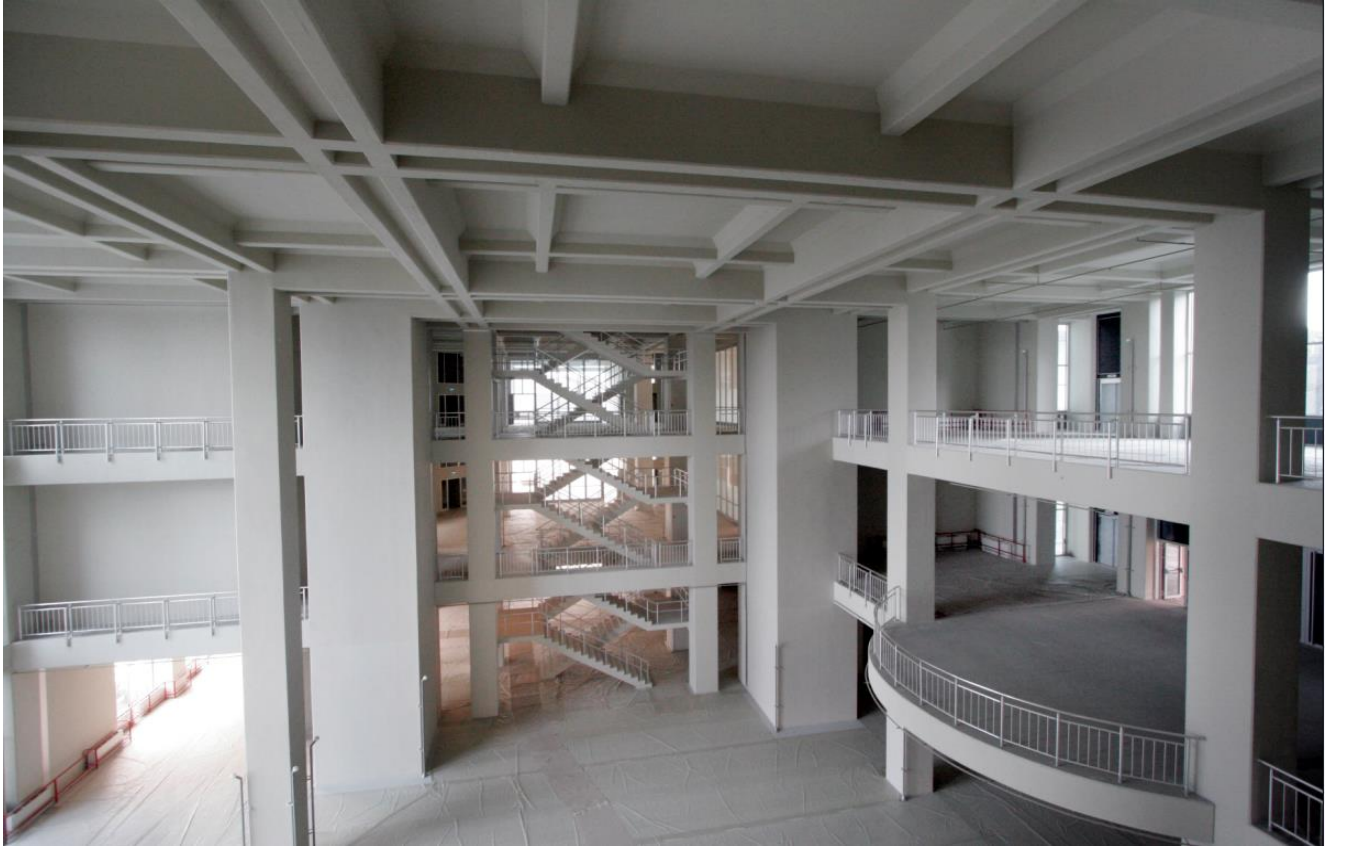
Bomonti kampüs inşaatı iç mekan görünüşü
